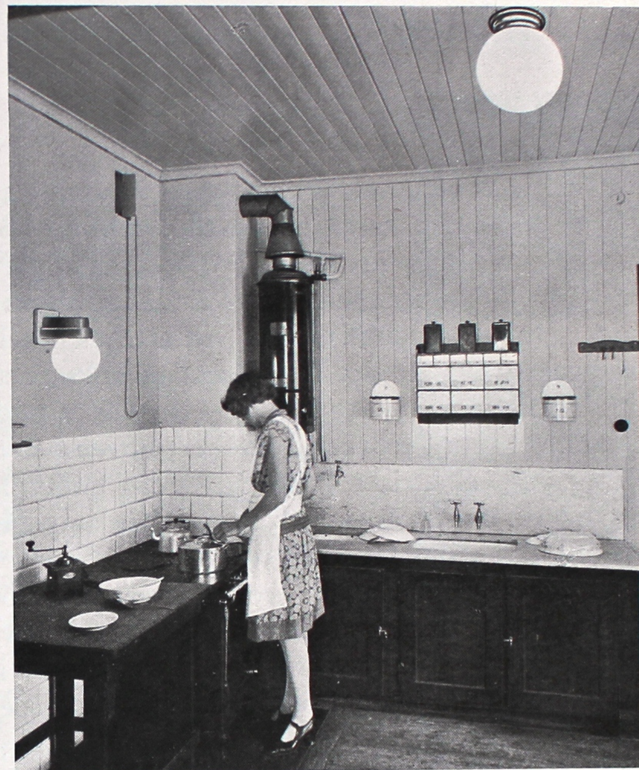
GOD KÖKSBEVYSNING. RIKLIGT, BLÄNDFRITT LJUS I HELA RUMMET. SLAGSKUGGAN HELT UPPHÄVD GENOM SPISLAMPAN
