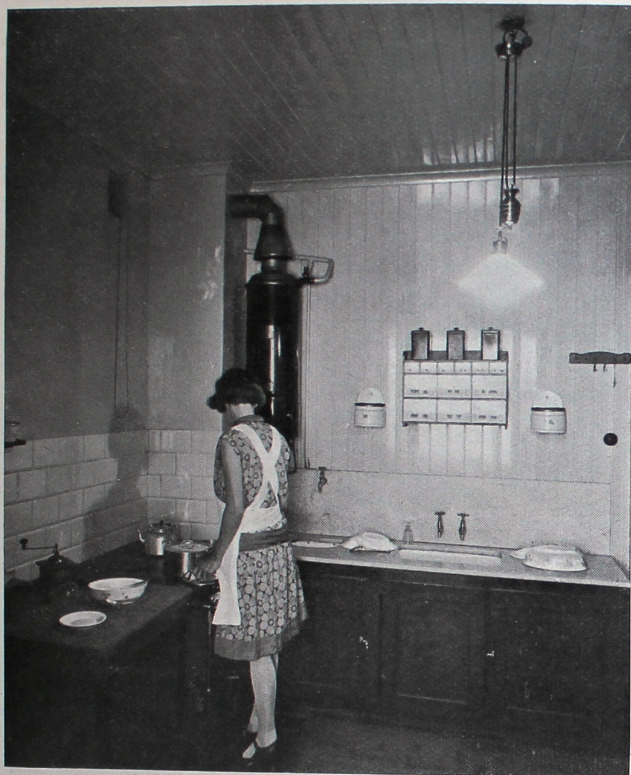
DÅLIG KÖKSBEVYSNING. FÖR SVAG BEVYSNING PÅ ARBETSPLATSERNA, BLÄNDNING, STÖRANDE SLAGSKUGGOR
