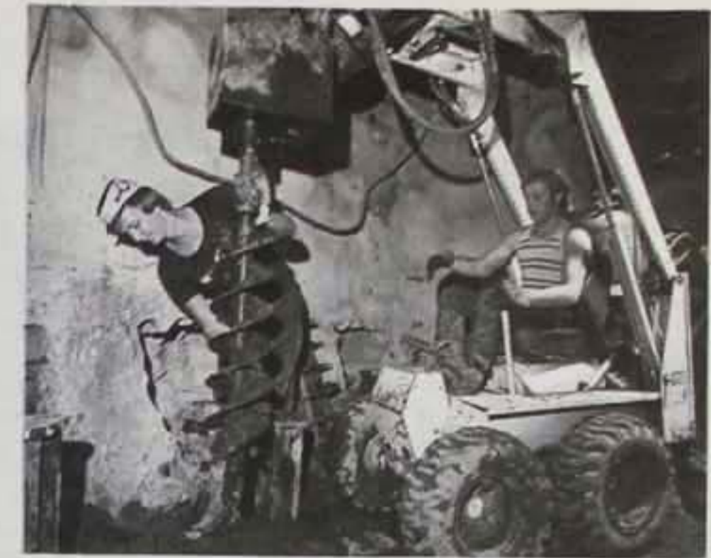
Bilden visar grundförstärkningsarbeten i samband med upprustning av ett bostadshus i Gamla Stan. Arbetet tillgår så att ett hål borras genom fyllningslagren varefter det fylls med bentonitlösning. En stältpåle förs sedan ned och drivs till stopp i grusåsen under fyllningen. Foto: Peter Josephson
