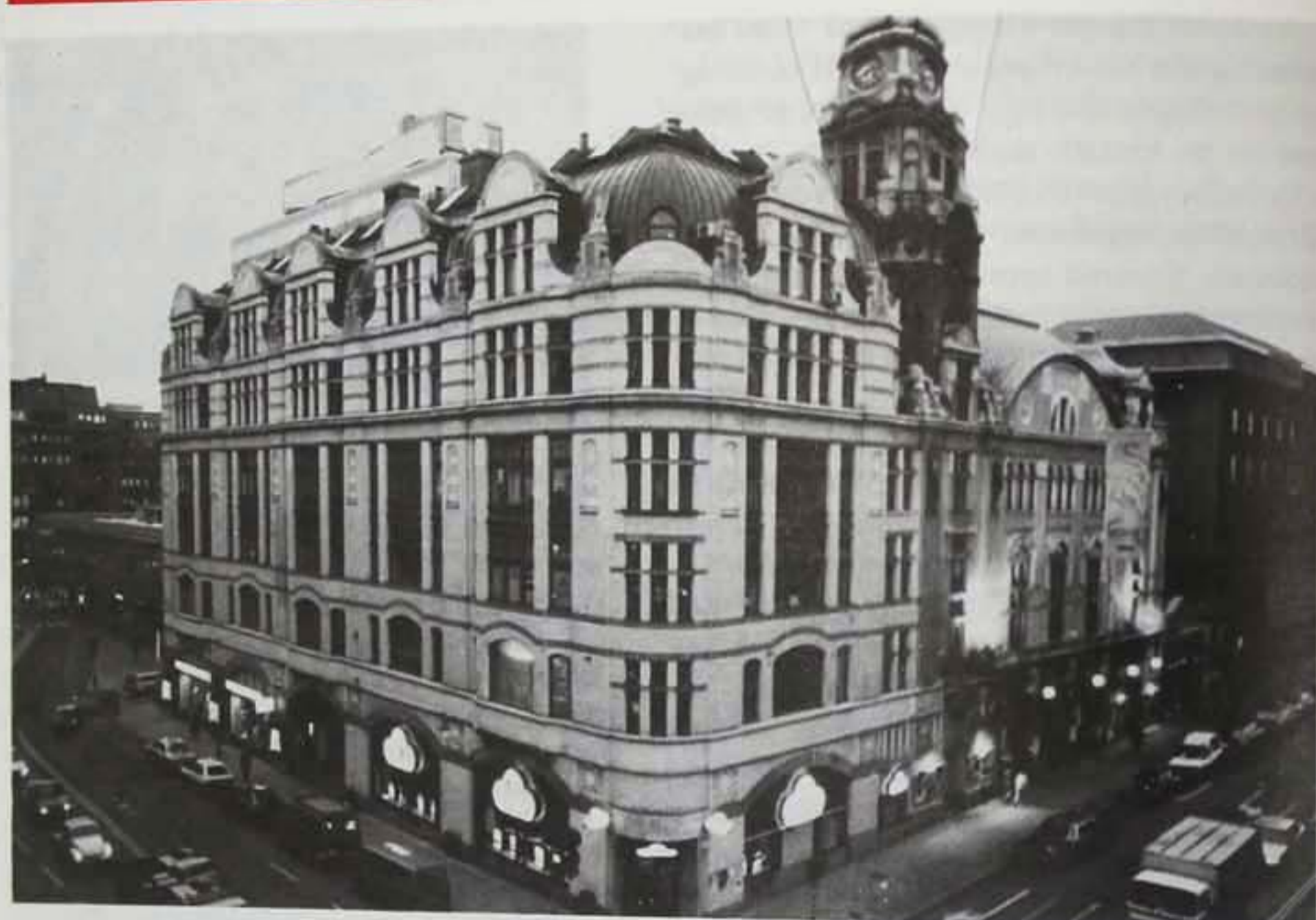
"Kungsbropalatset" (Hasseln 5) i hörnet Vasagatan/Kungsgatan ägs av kommunen och förvaltas av fastighetsnämnden. Byggnaden innehåller ca 4 000 m 2 bruksarea. Tak och fasader är nyligen renoverade. Under 1982 påbörjas inre upprustning och ombyggnad för totalt ca 10 Mkr. Foto: Staffan Brunborg och Karl Fritsche
