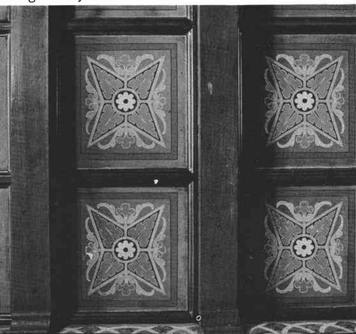
Lägrret 9, tak i entré
