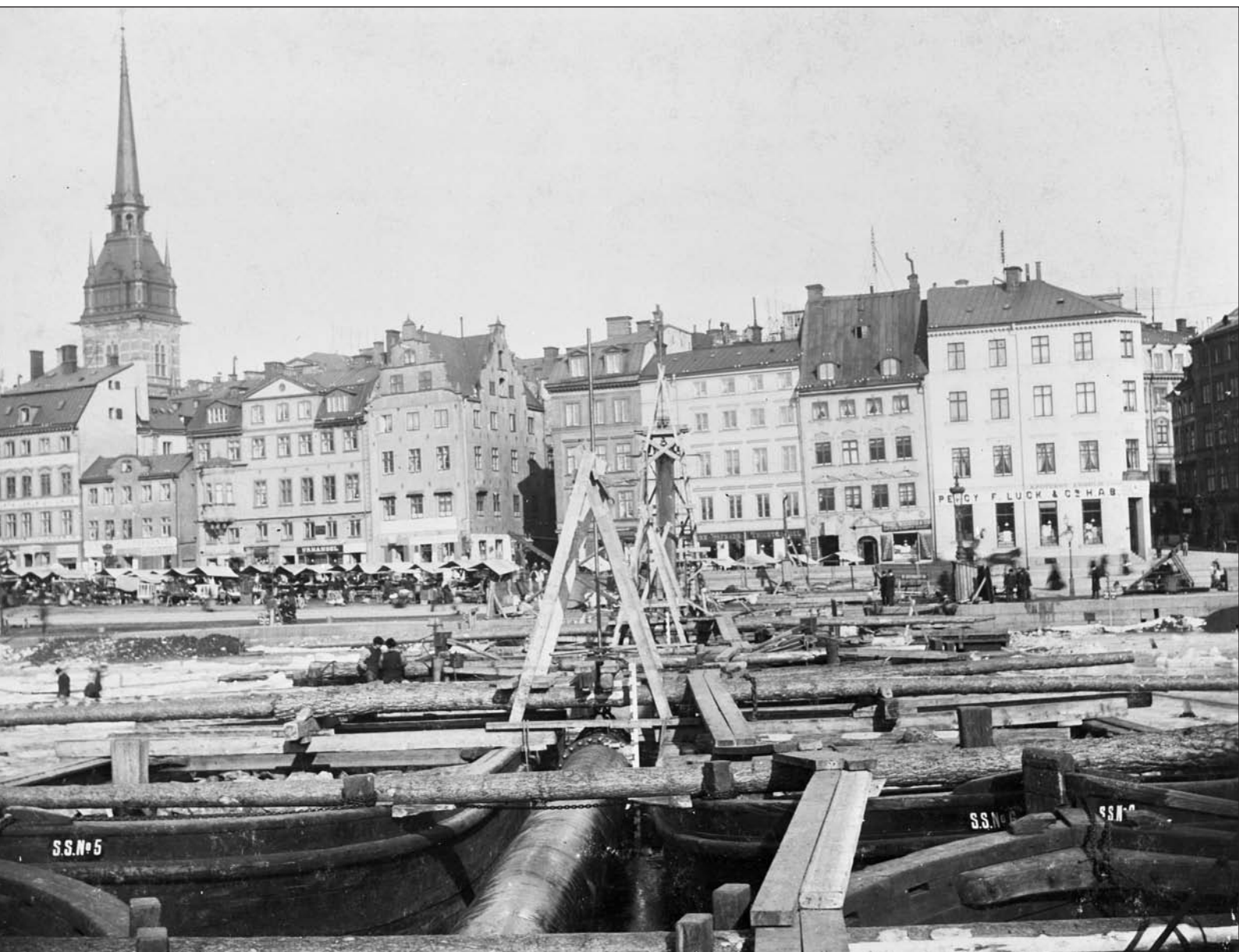
Fig. 25. Undervattenledningsarbeten 1899 invid Kornhamnstorg från Sjöbergs plan. Foto SSM Fa 3643.
