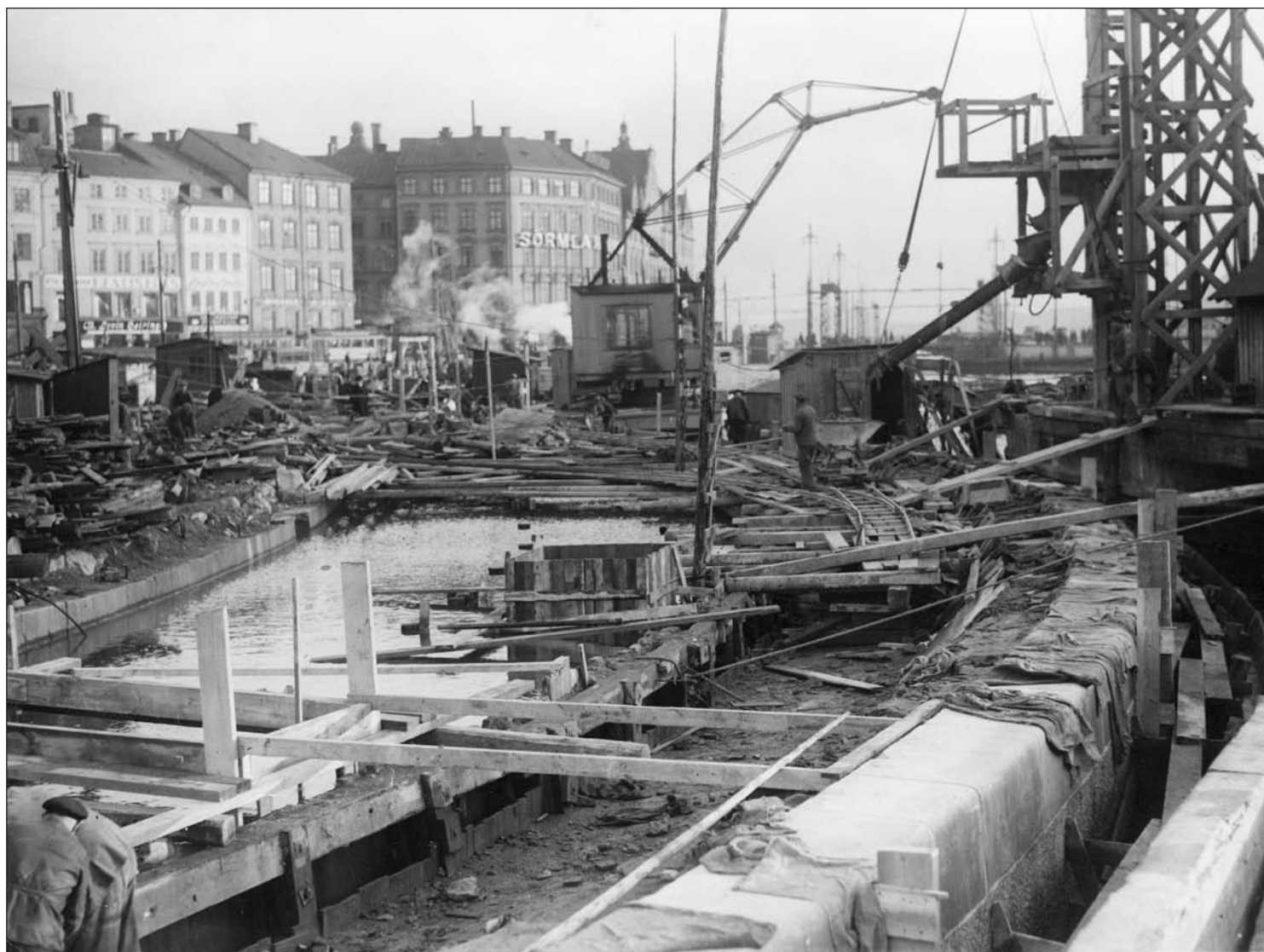
Fig. 21. Kornhamnstorg utvidgas åt söder. Foto SvD 1930. SSM A 152/47
