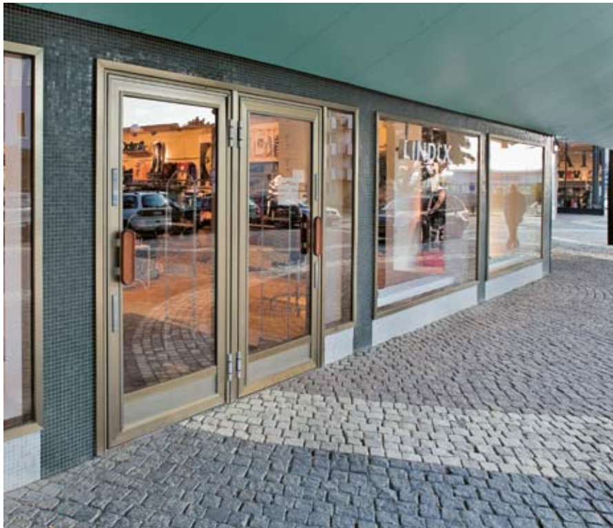
Ett återställt parti med skyltfönster och butiksentréer omramat av glasmosaik. Foto: Göran Fredriksson, SSM, 2008.
