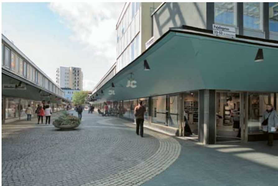
Vällingbygången mellan hus K och I, med den lägre delen av Svenska Bostäders kontorshus till vänster. Vy mot »Blå huset«. De strutformade lamporna är nytillverkade efter den ursprungliga modellen. Foto: Göran Fredriksson, SSM, 2008.
