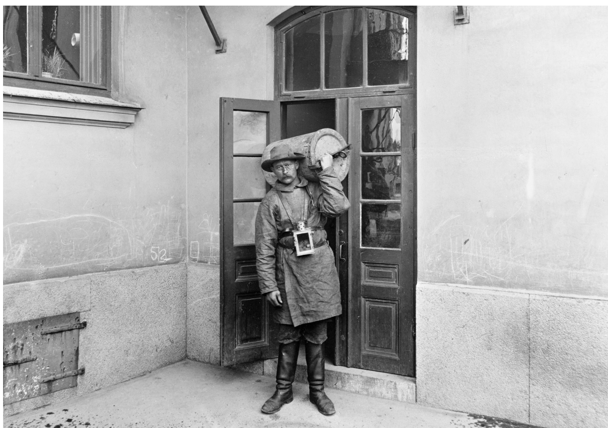
Latrintunnor hämtades från stadens fastigheter för att tömmas på prämar som låg vid kajerna eller i någon av de över 100 latringropar som ännu fanns i staden 1877. Först 1909 blev det tillåtet att ansluta wc till stadens avloppsnät. Foto från 1890-talet.
