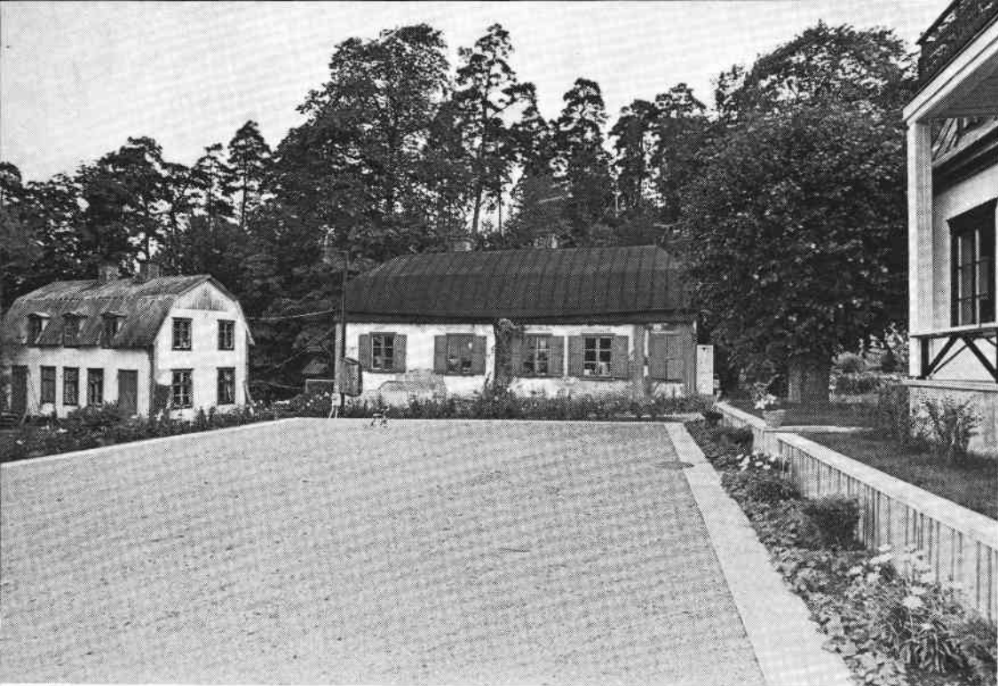
Johannesdals gård. Den äldsta byggnaden är flygeln. Foto stadsmuséet 1968.
