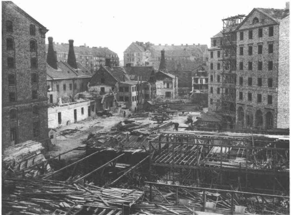
Fig 43 Rivning och byggnader under uppförande på Rörstrandsområdet. Foto 1920-talet.
