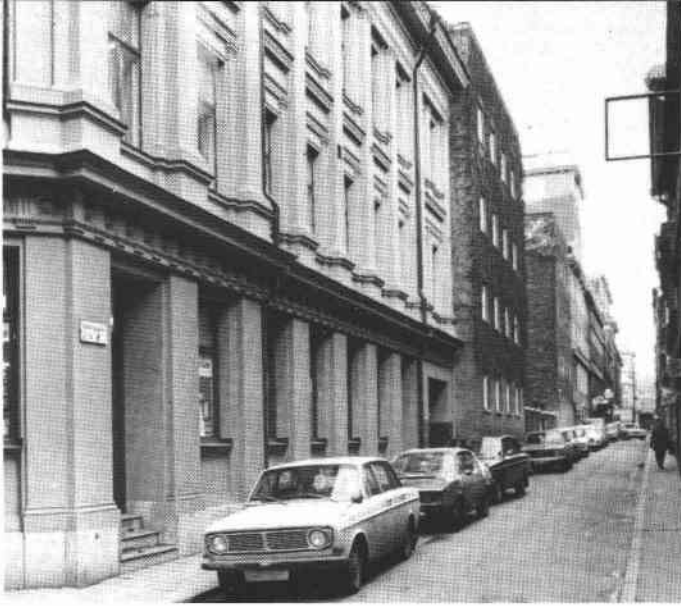
Kvartersfasad mot Apelbergsgatan
