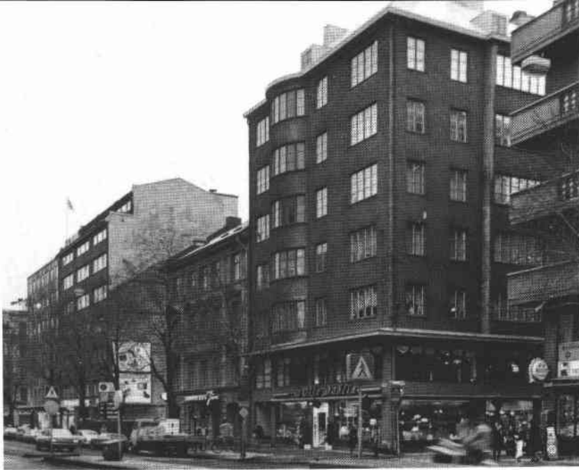
Kvartersfasad mot Sveavägen
