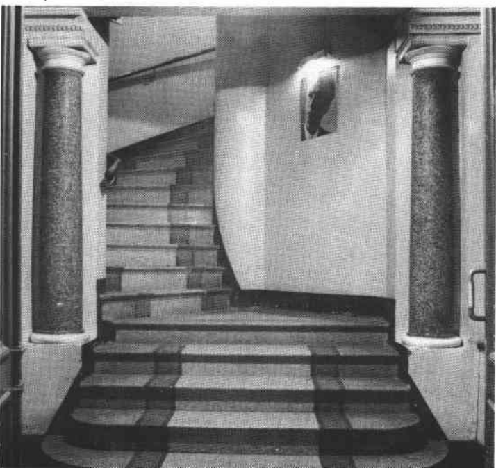
Bryggmästaren 1, södra trapphus
