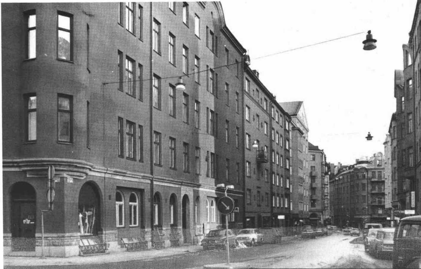
Kvartersfasad mot Wallingatan
