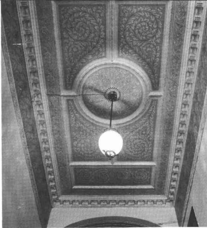
Kurland 17, tak i entré
