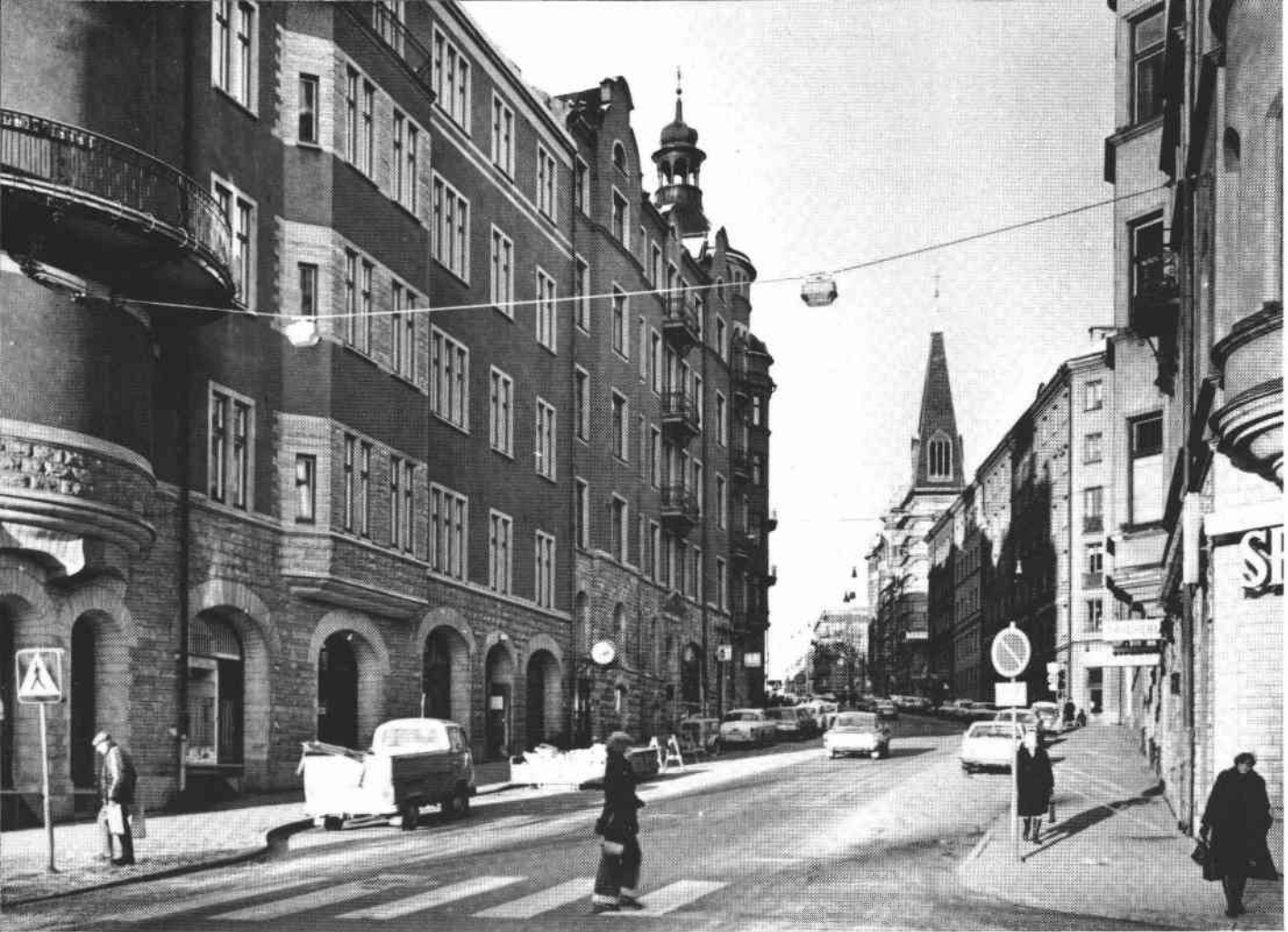
Upplandsgatan norrut vid Norra Bantorget
