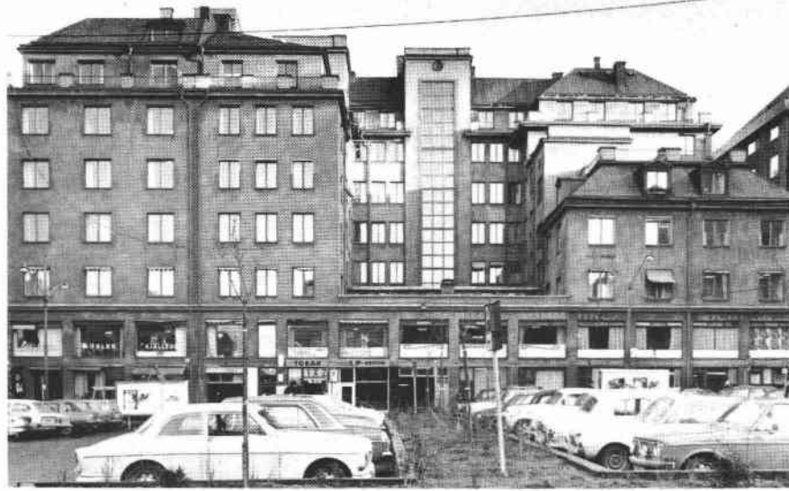
Sejlaren 7, fasad mot Olofsgatan
