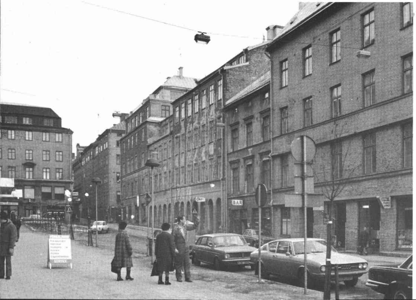
Kv Tigern, fasad mot Jakobsgatan
