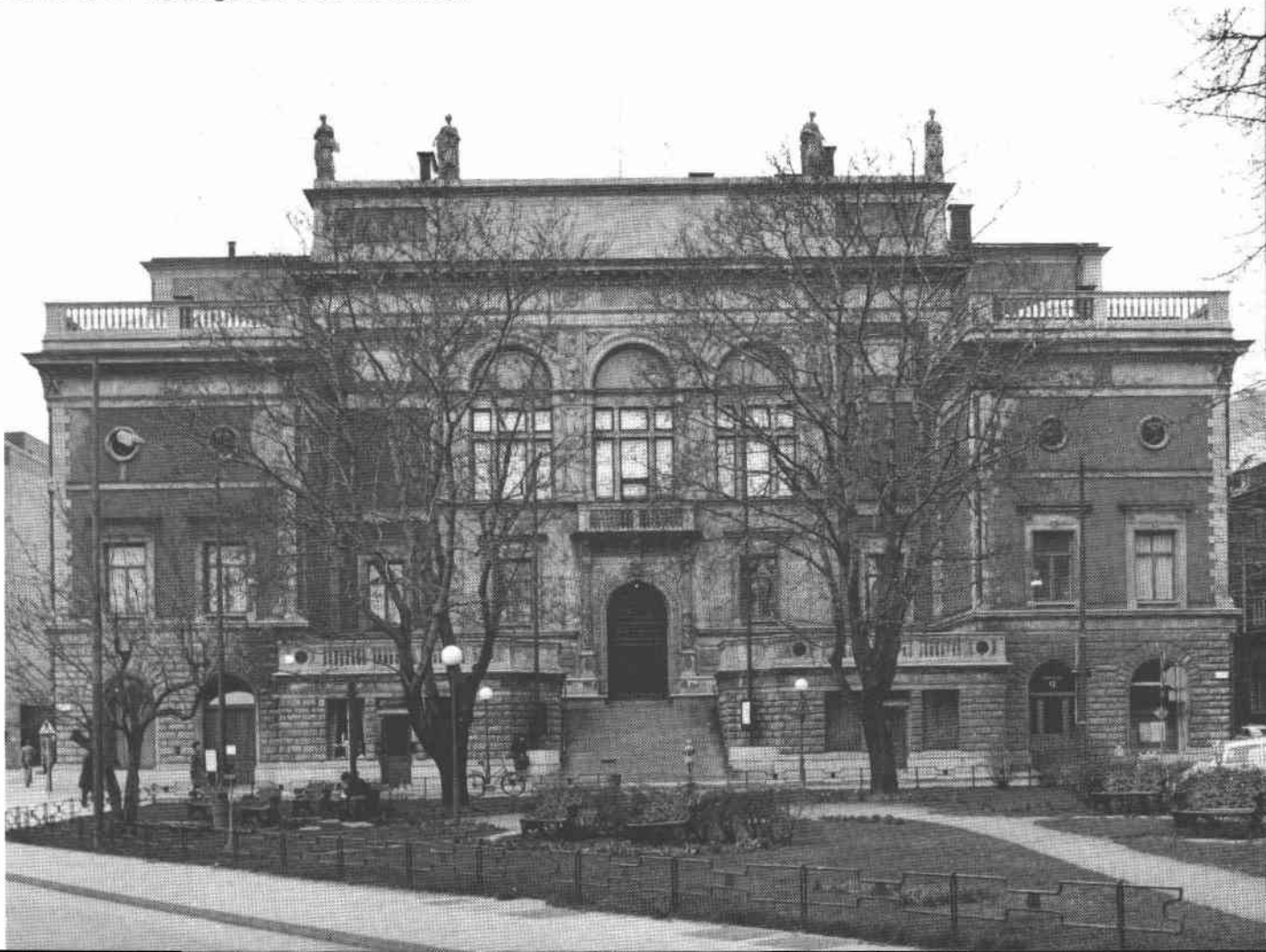
Fasad mot Fredsgatan och Rosenbad
