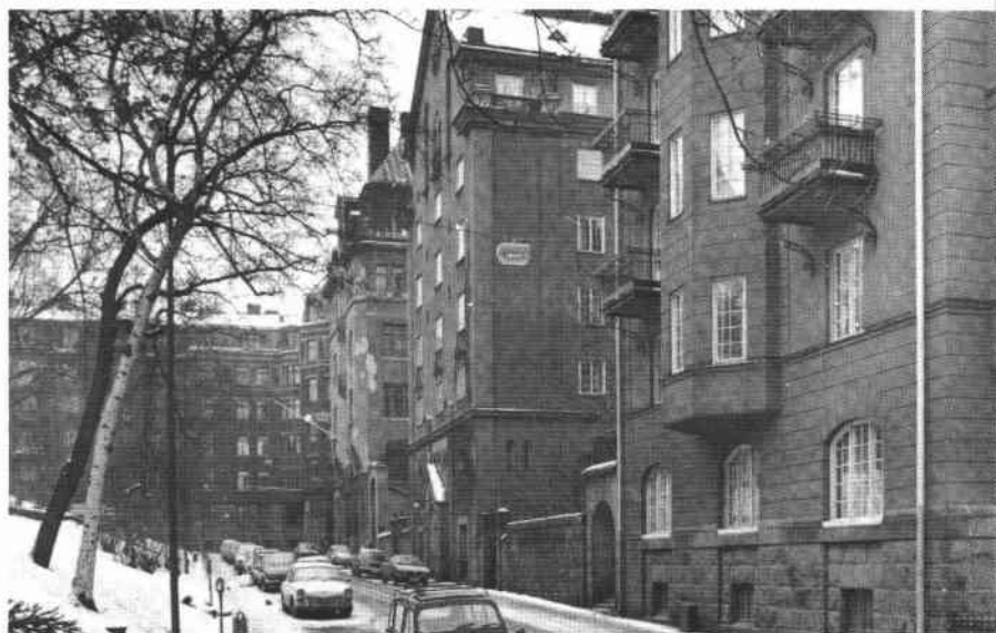
Kvartersfasad mot Tegnérlunden
