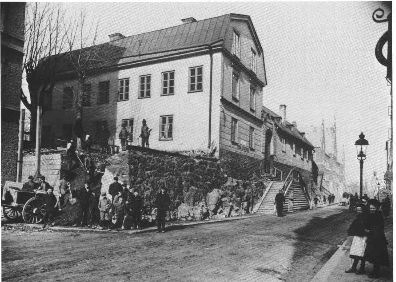
Blåkråkan 1 och Roslagsgatan norrut. Lilla Ingemarshov, på den gamla högre gatunivån, är numera rivet. Foto april 1904.
