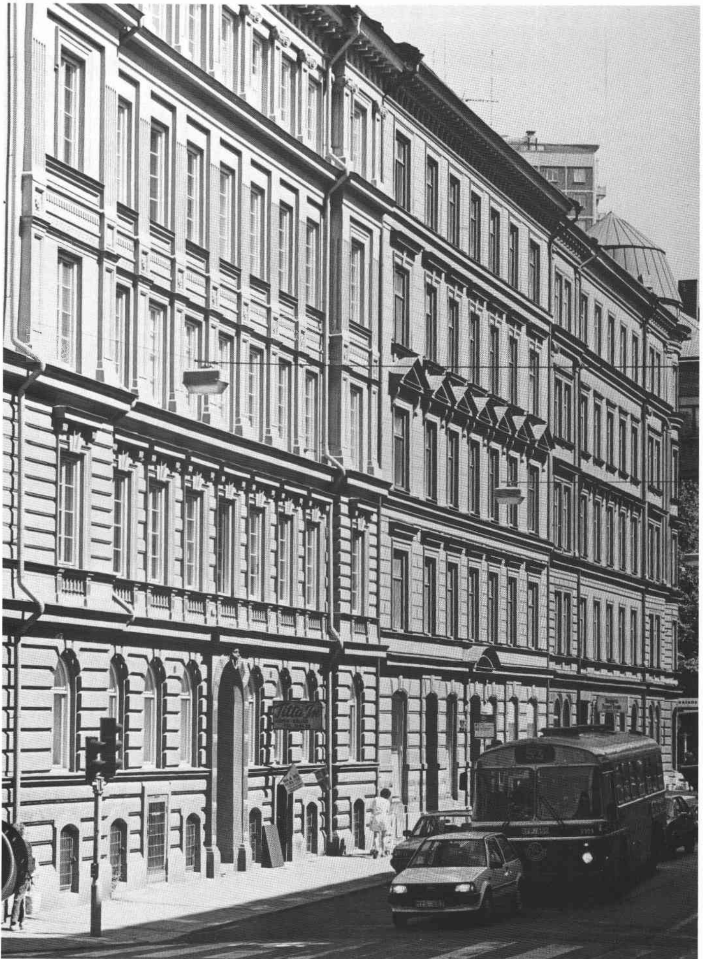
Kvarteret Ingemar. Fasaderna mot Frejgatan.
