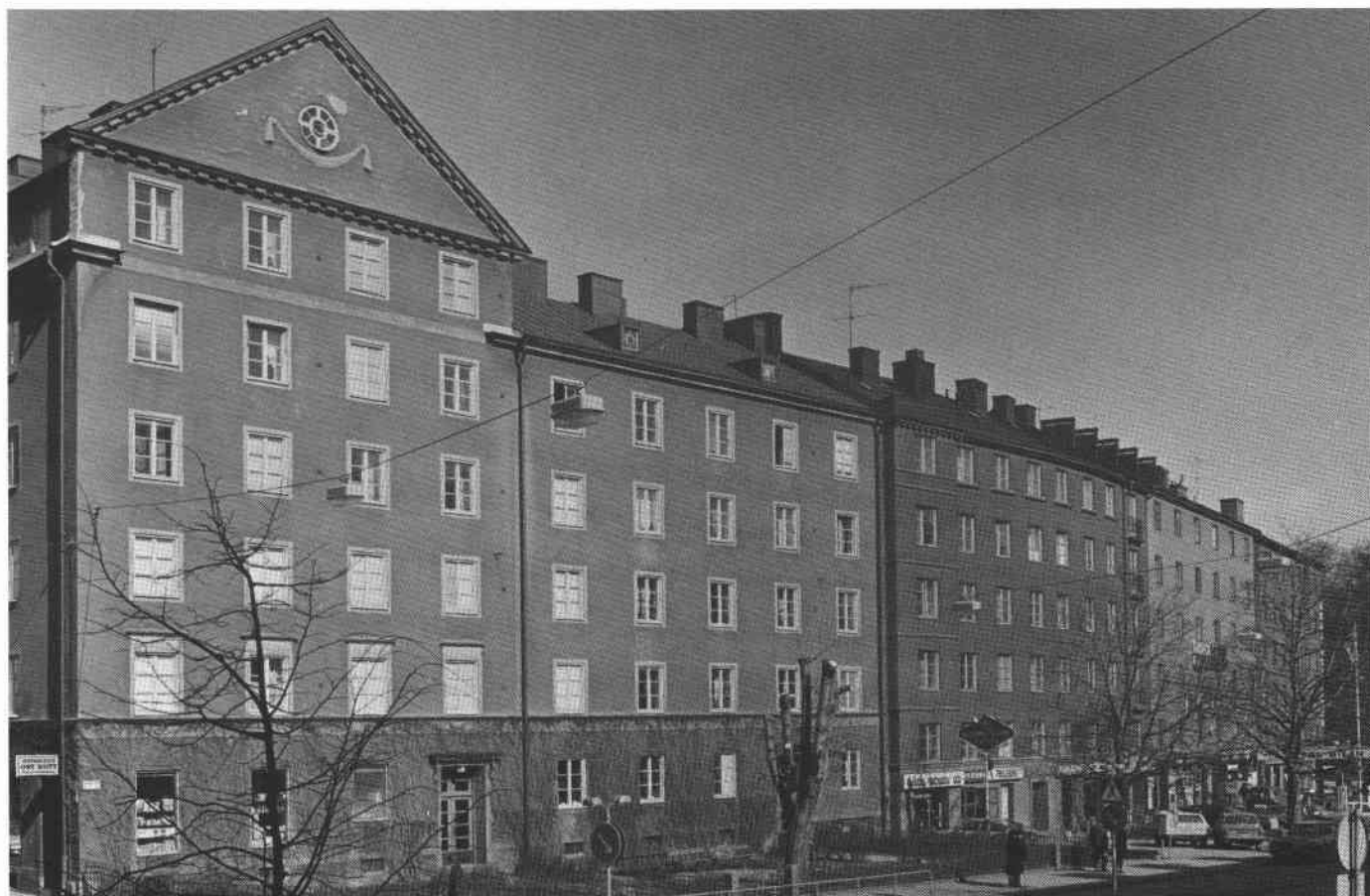
Kvarteret Munin, gatufasader mot Vanadisvägen.
