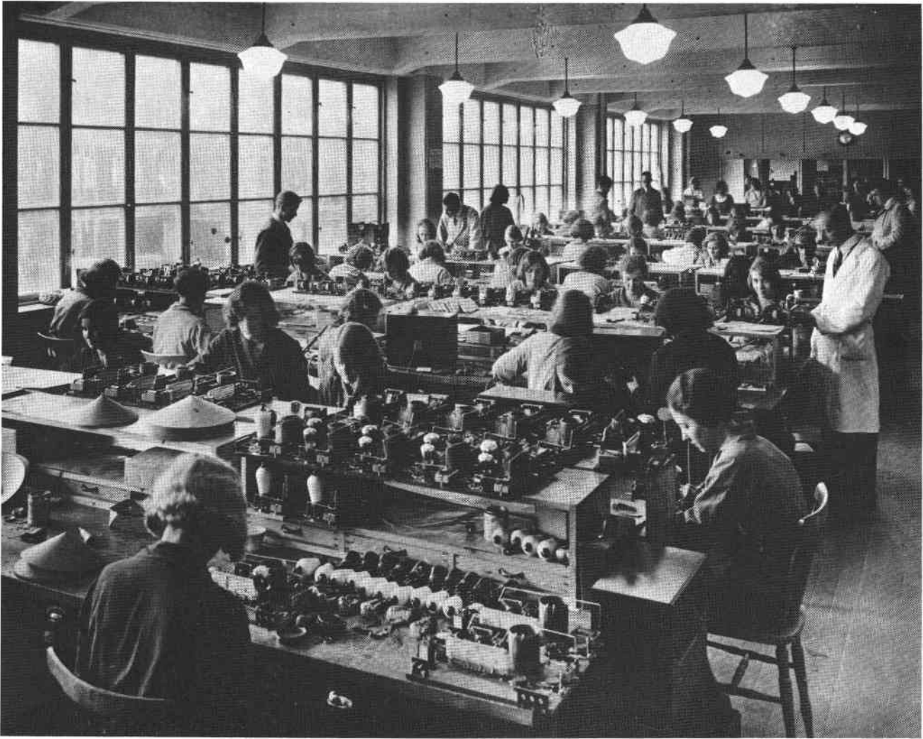
Blästern 5. Monteringsal i industricentralen.
