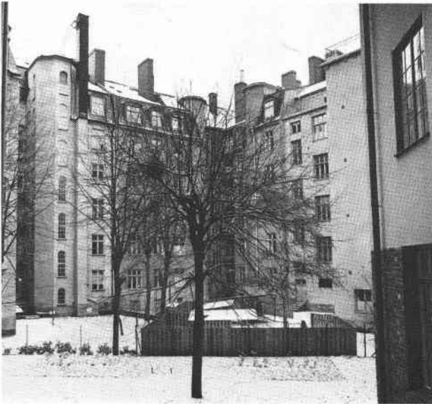
Gårdsvy från Kornetten 9 mot Kornetten 3, 4 och 5.
