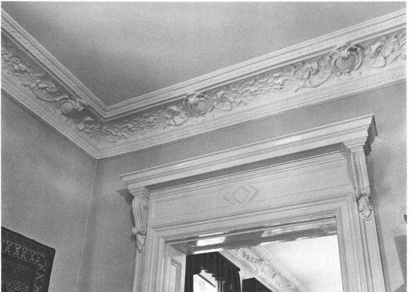
Rackelhanen 2, takstuckatur och dörröverliggare.
