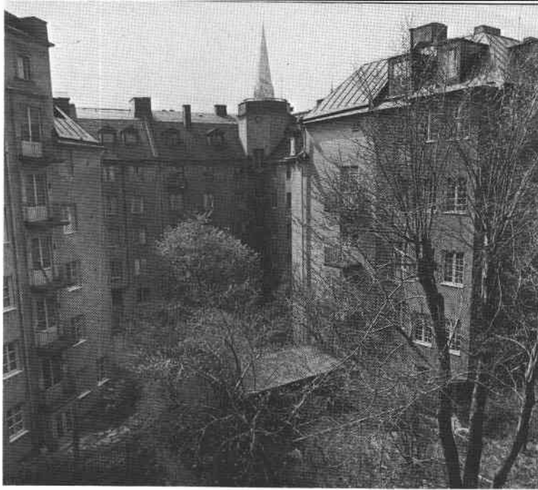
Kv. Norrtälje, gårdar mot nordväst.
