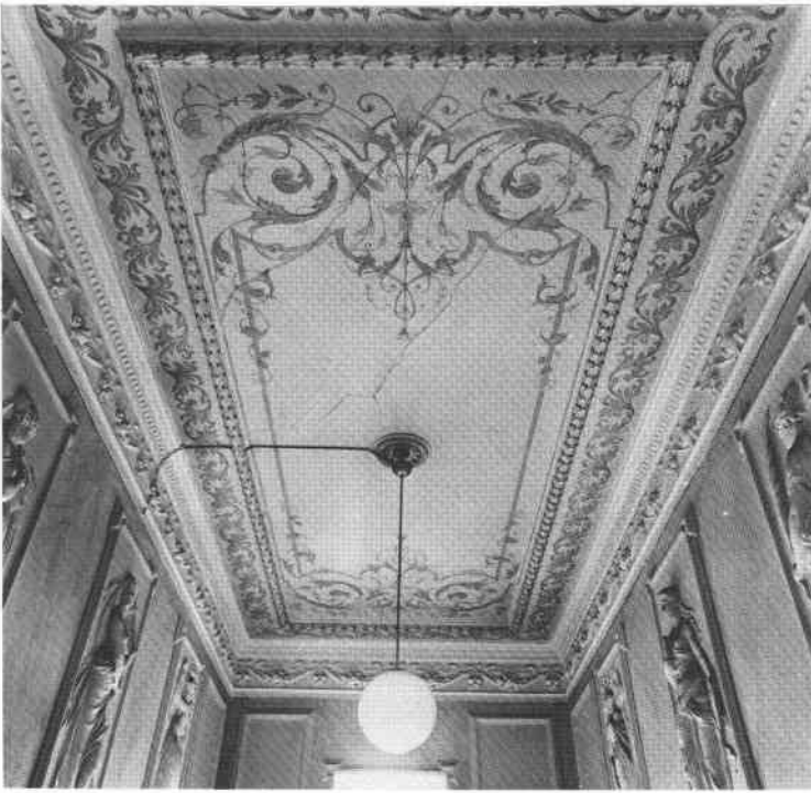
Karlavagnen 11, takmålning i entré.
