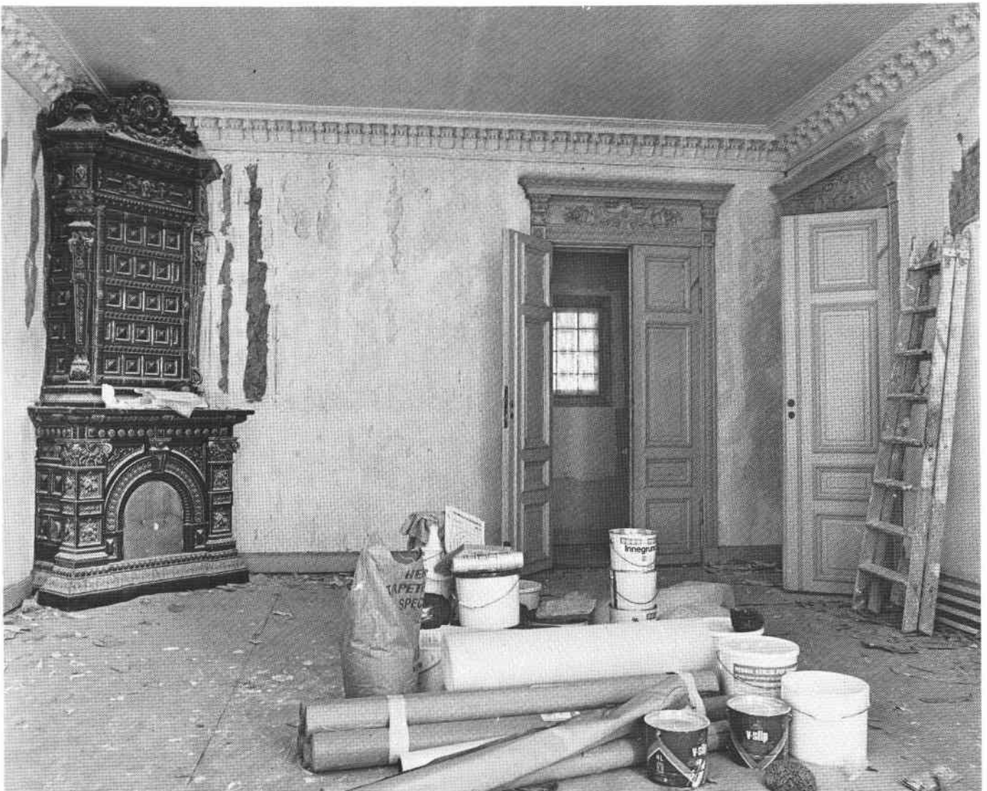
Kungsbacken 9, lägenhet under ombyggnad.
