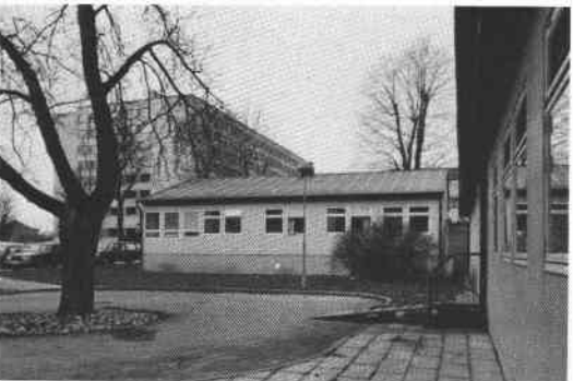
Hus VIII - idag logopedmottagning m m (urspr foniatrik avd + barndaghem). Byggnadsår 1965-70, arkitekter Uddenberg & Hjelmsen, byggherre Sabbatsbergs sjukhus.
