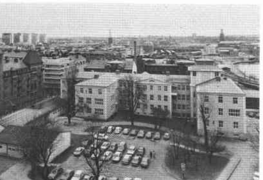
Hus IX - administrationsbyggnad (f d vårdbyggnad, "Ögon och öron"). Byggnadsår 1908-11, arkitekt G Wickman, byggherre Sabbatsbergs sjukhus. 1925-28 tillbyggnad västerut samt påbyggnad med 1 vån. 1973 ombyggnad för kontorsändamål.
