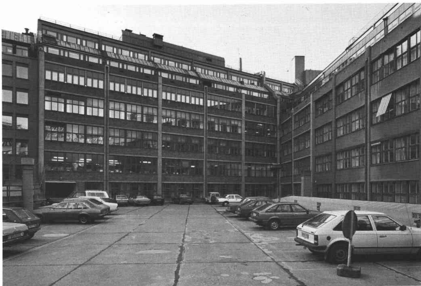
Gårdsfasad av hus I. S82-0486-8.
