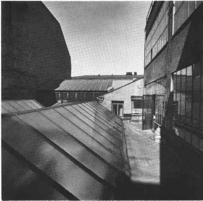
Den överbyggda gården (IIIb) från söder. S82-0254-12.
