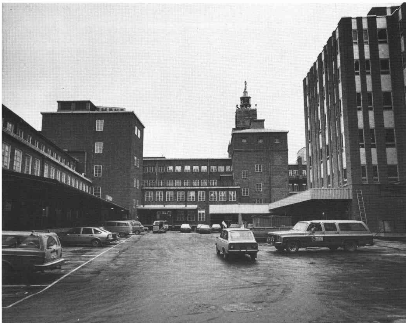
Hus I gårdsfasad mot Hälsingegatan. T.h. nybyggnaden från 1980. S82-0488-8.
