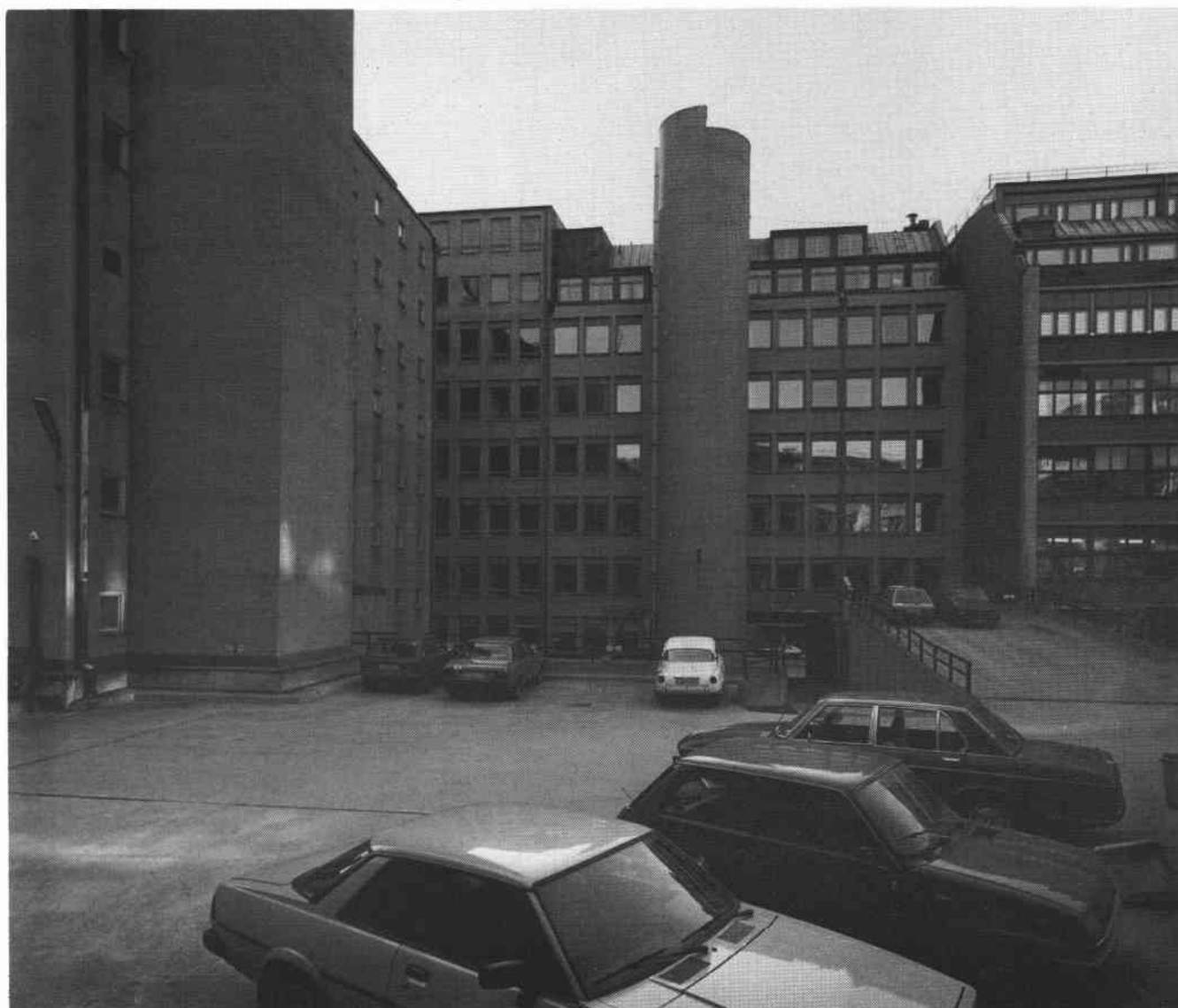
Gårdsfasad av hus Ia och II, lagerhuset Ib t.v. S82-0489-9.
