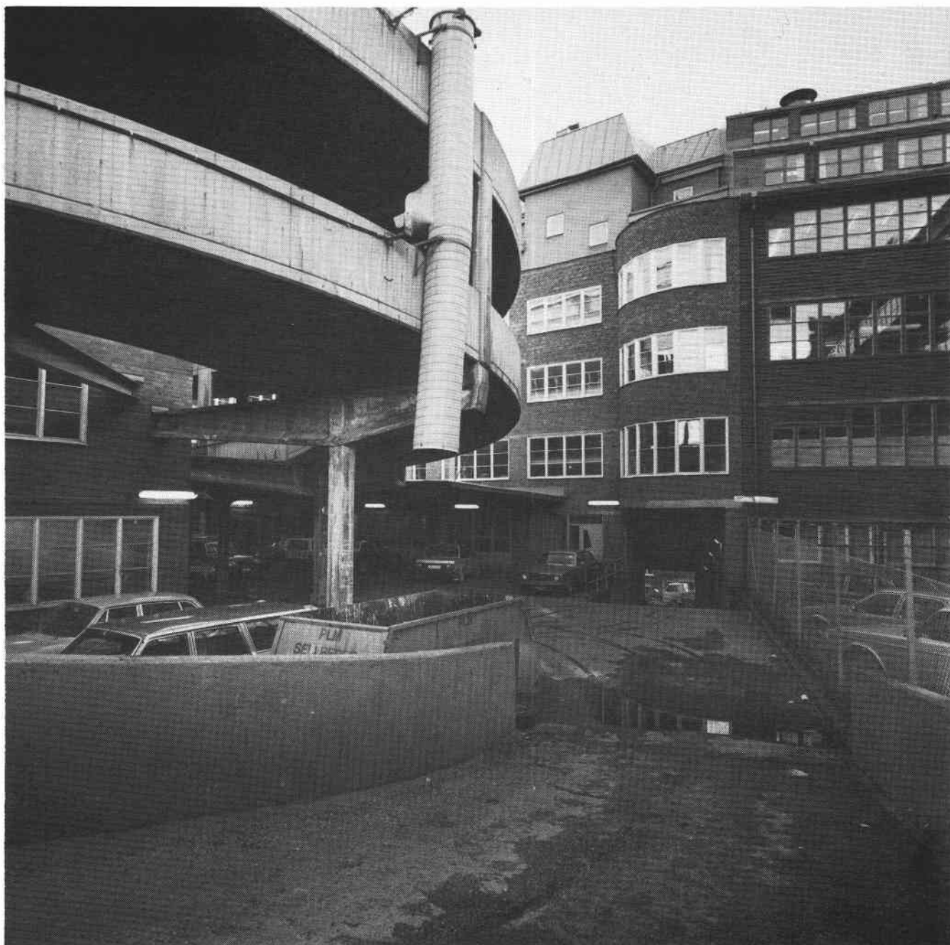
Bilrampen på byggnadens norra gårdsfasad. S82-0487-2.
