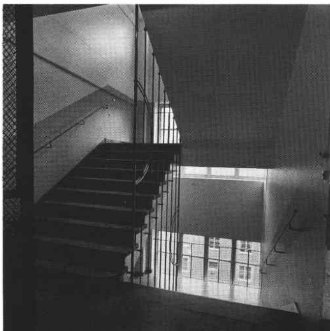
Trapphus i fastigheten 4, hus II. S82-0433-8.
