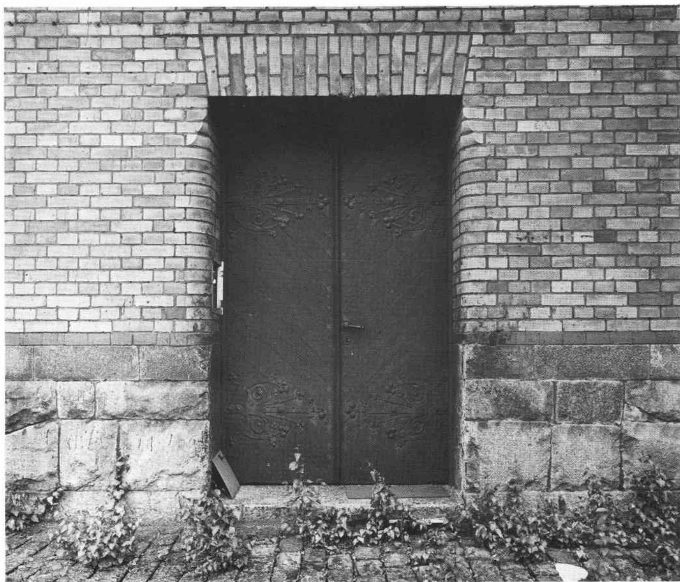
Dörr med smidda järnbeslag efter F Bobergs ritningar. Hus 68. Foto 1979. FB13692.
