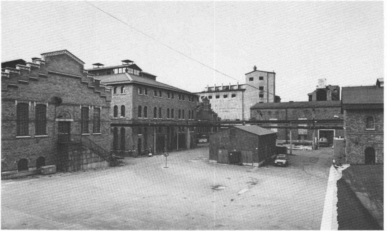
Från vänster mätareförråd (30), reningshus IoIV och II (29 och 27-28), transformatorstation U5 (38), maskincentral (49) och längst t.h. verkstadshus I (37). I fonden kokssorteringsverken IV och III (25 och 64). S82-0402-12.
