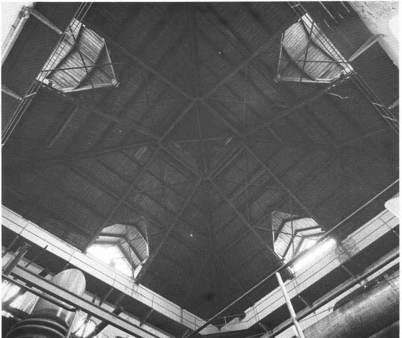
Taket i f.d. kondensatorhuset (68). S82-0403-6.
