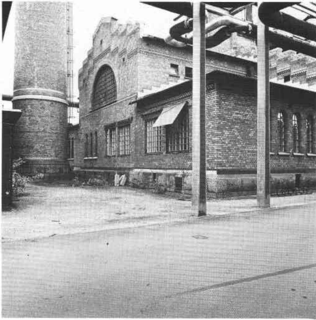
Skorstenen (59) och västra änden av retorthuset (56), 1979. FB 13695.
