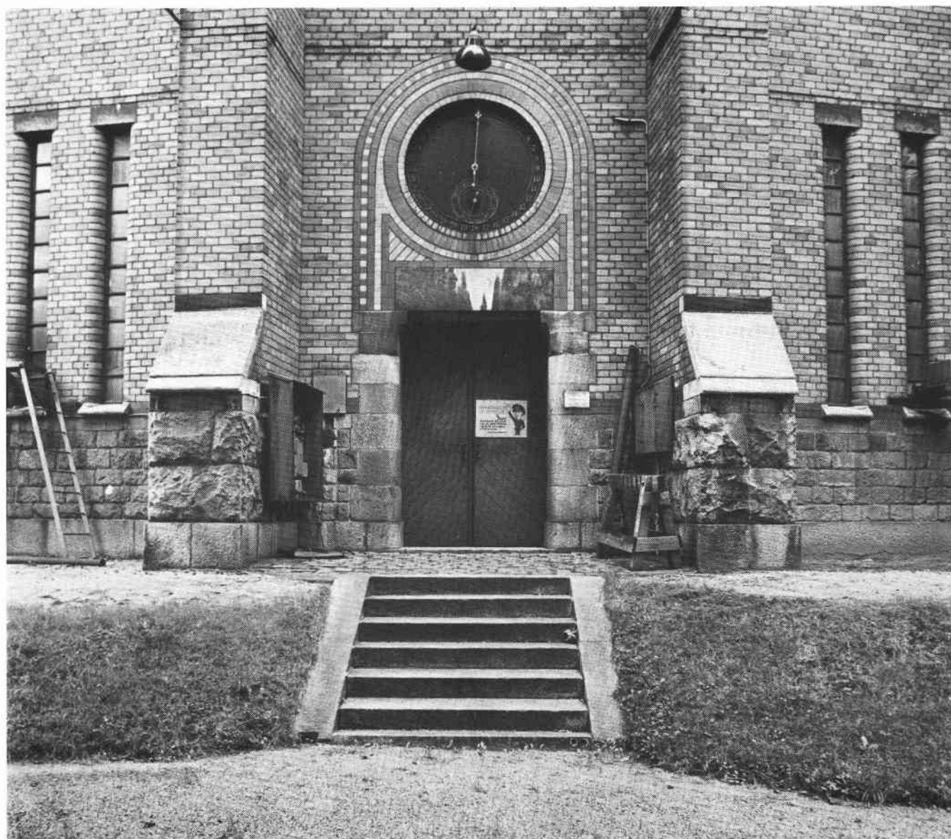
Entré till klockhuset (17). Över dörren sitter gasmätaren. Foto 1979. FB 13680.
