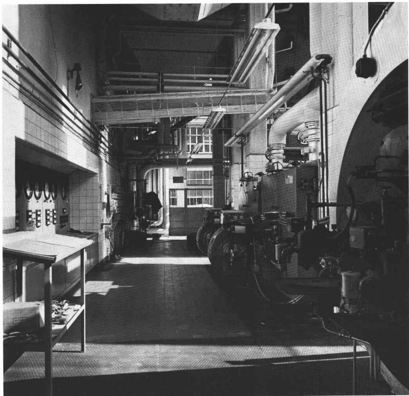
Ångpannehuset. Foto 1979. FB 13702.
