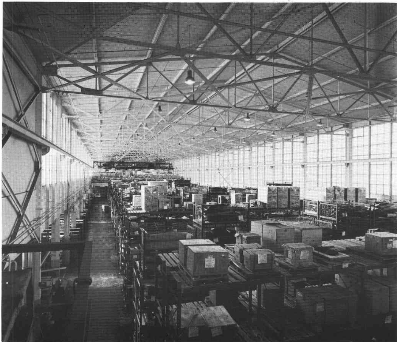
Det norra skeppet. Reservdelslagret. S82-0490-3.
