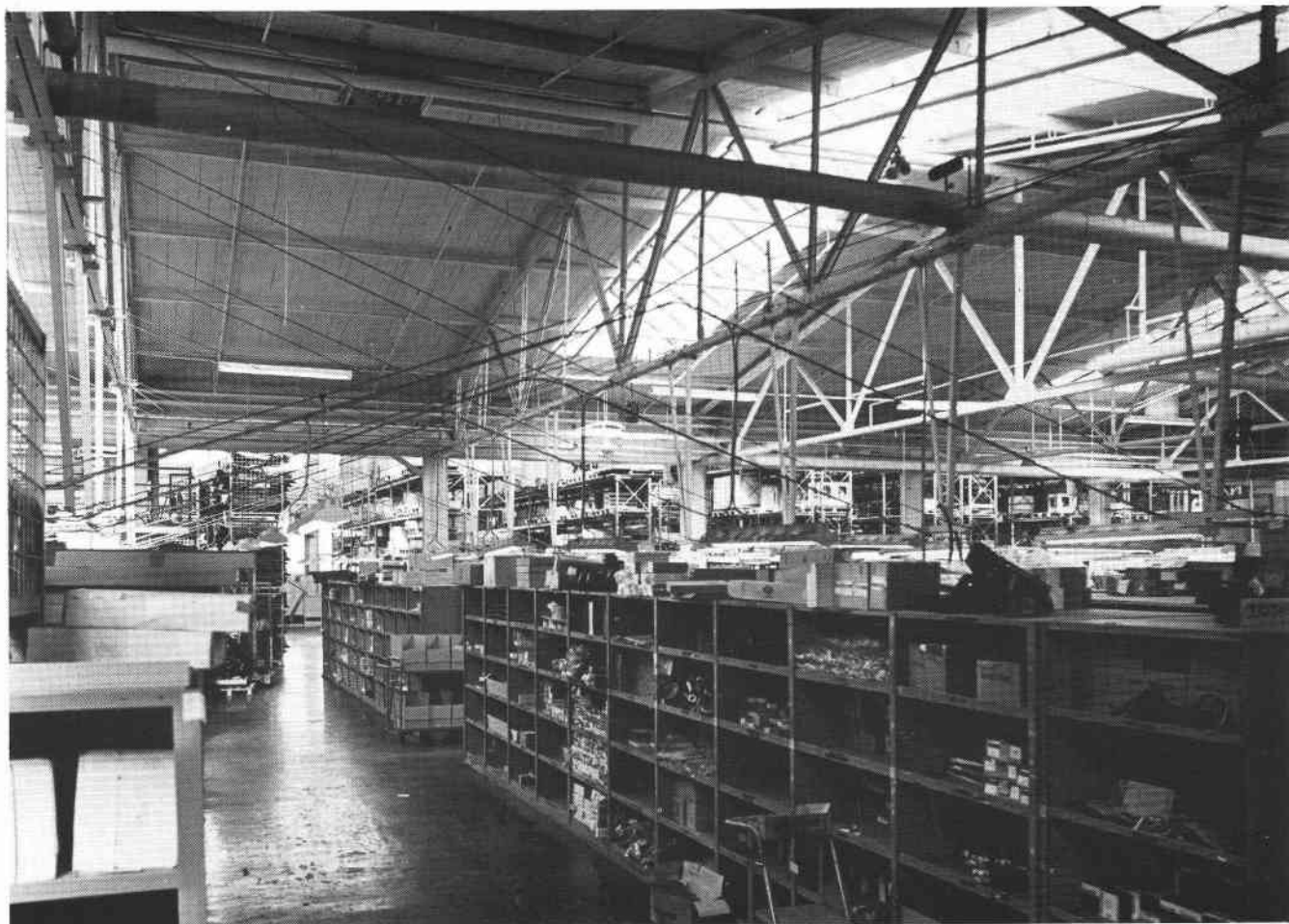
Anläggningens mittdel. Foto 1979. FB 13708.
