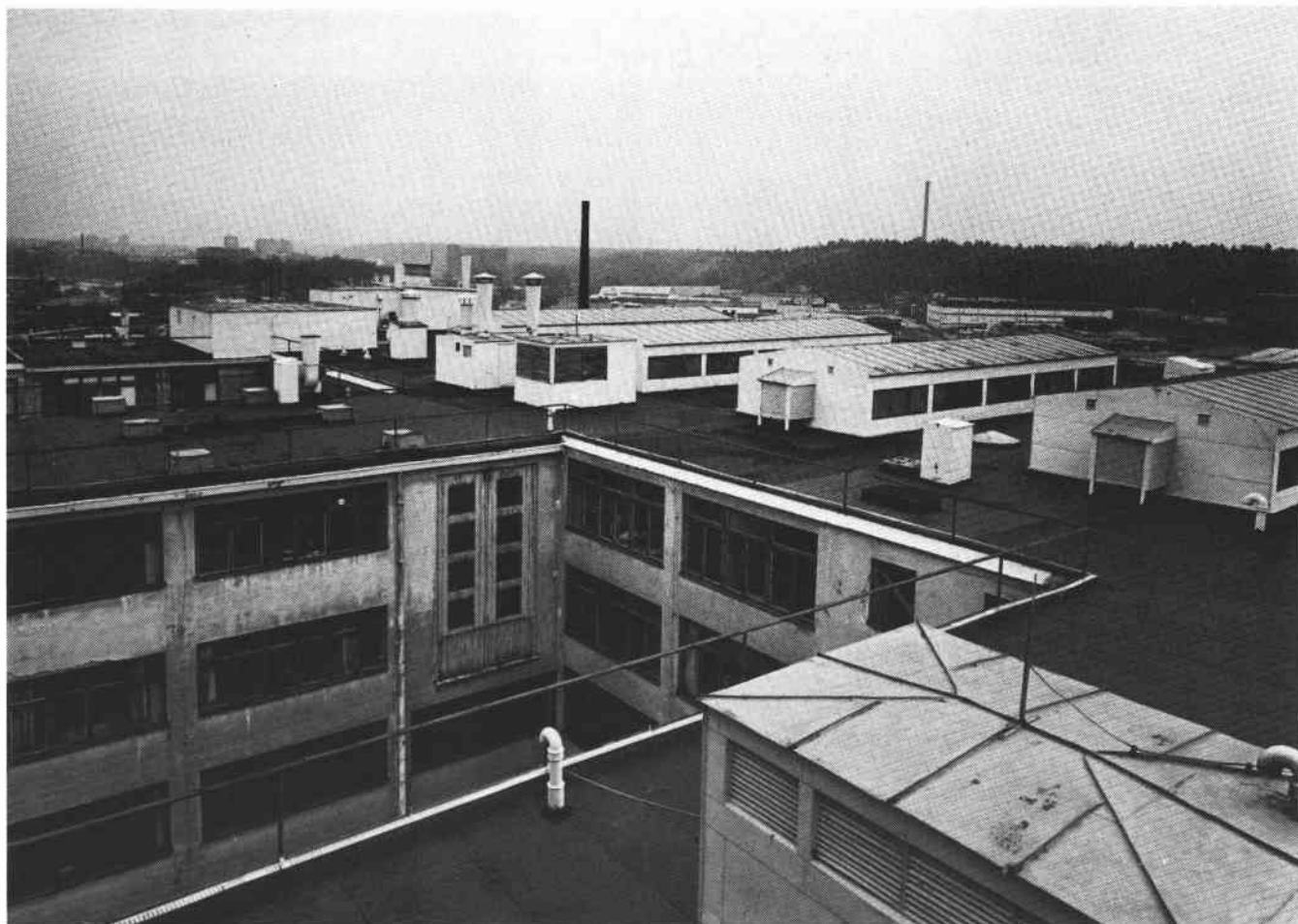
Takparti av hus 1 mot söder. T.v. mellersta flygeln med dörr till ställverket. S82-0497-1.
