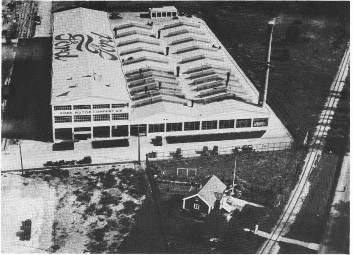
Anläggningen före utbyggnaden 1946. Originalfoto hos Ford Motor Company. Refoto i SSM. Fa 27928.
