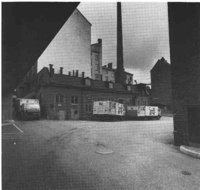
Infart till anläggningen. I fonden hus III. S82-0290-3.
