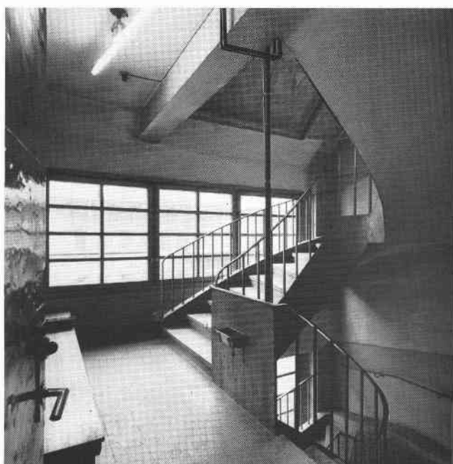
Trapphus i tryckeribyggnaden I. S82-0382-11.
