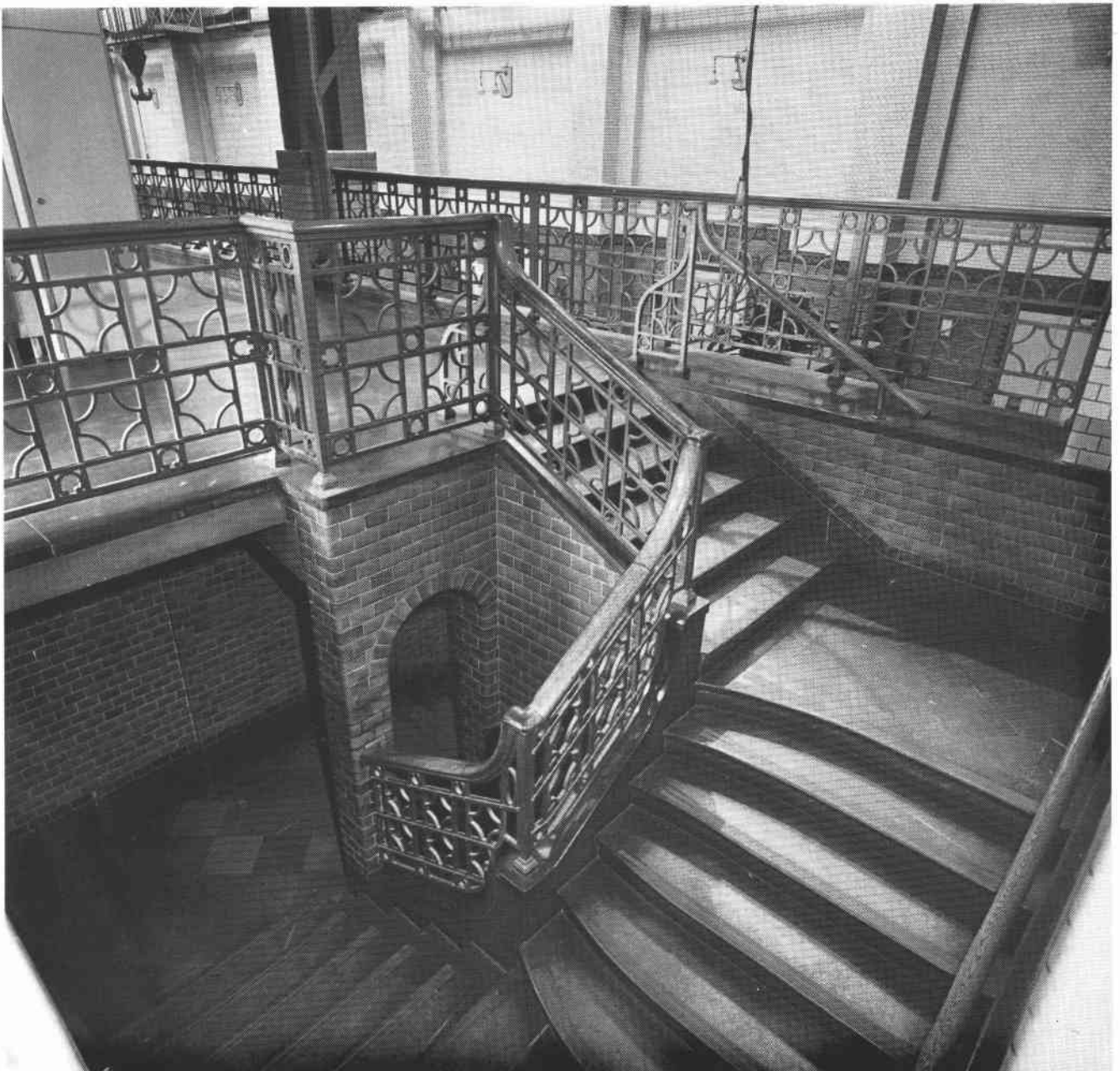
Trapphus i husdel I b med Ferdinand Bobergs omsorgsfulla detaljutformning. S82-0338-10.
