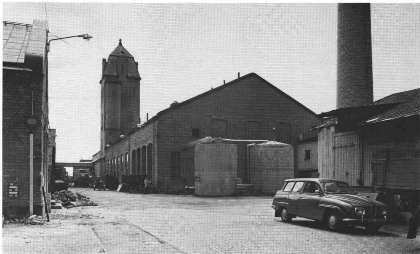
Ångpanne- och maskinhuset samt vattentornet (15) från norr. Foto 1979. FB 13117.
