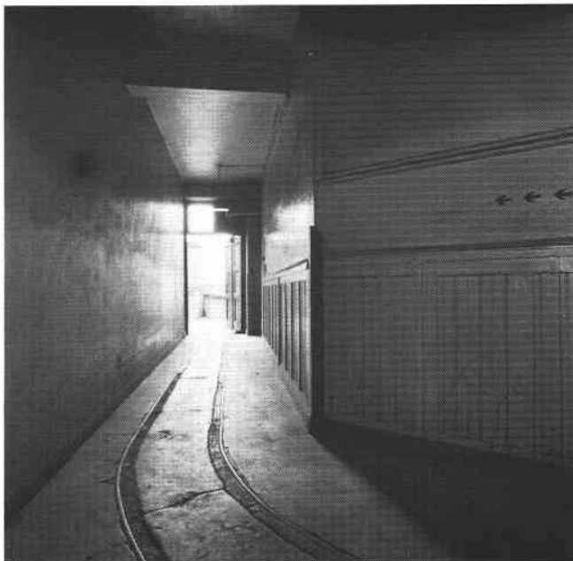
Spår för transportvagnar från byggnadens inre ut på gården. Hus IIc. S82-0295-4.
