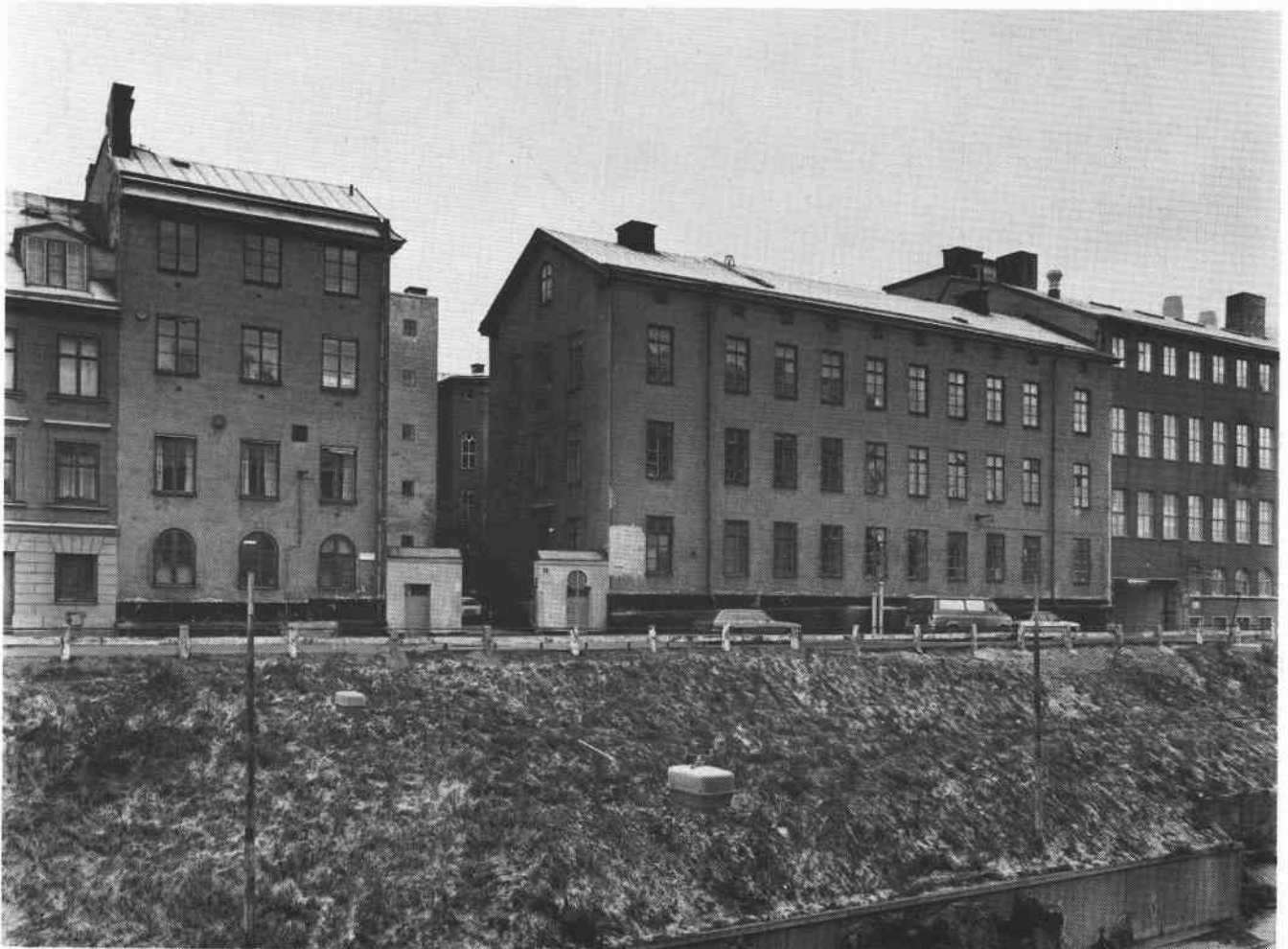
Fastigheten från väster, 1979. FB 14344.
