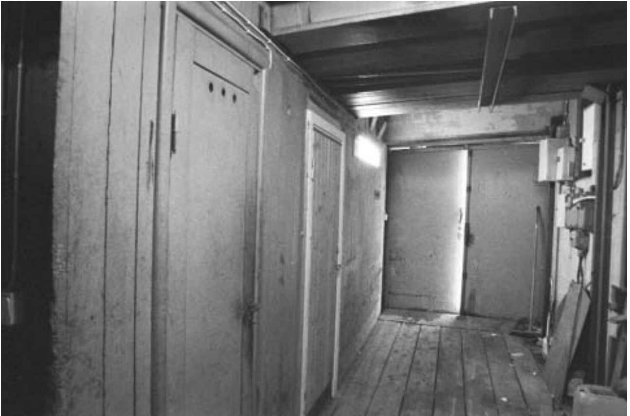
Interiörbild från förrådslokalen över avtappningskanalen. GF S2005-0038-12A.
