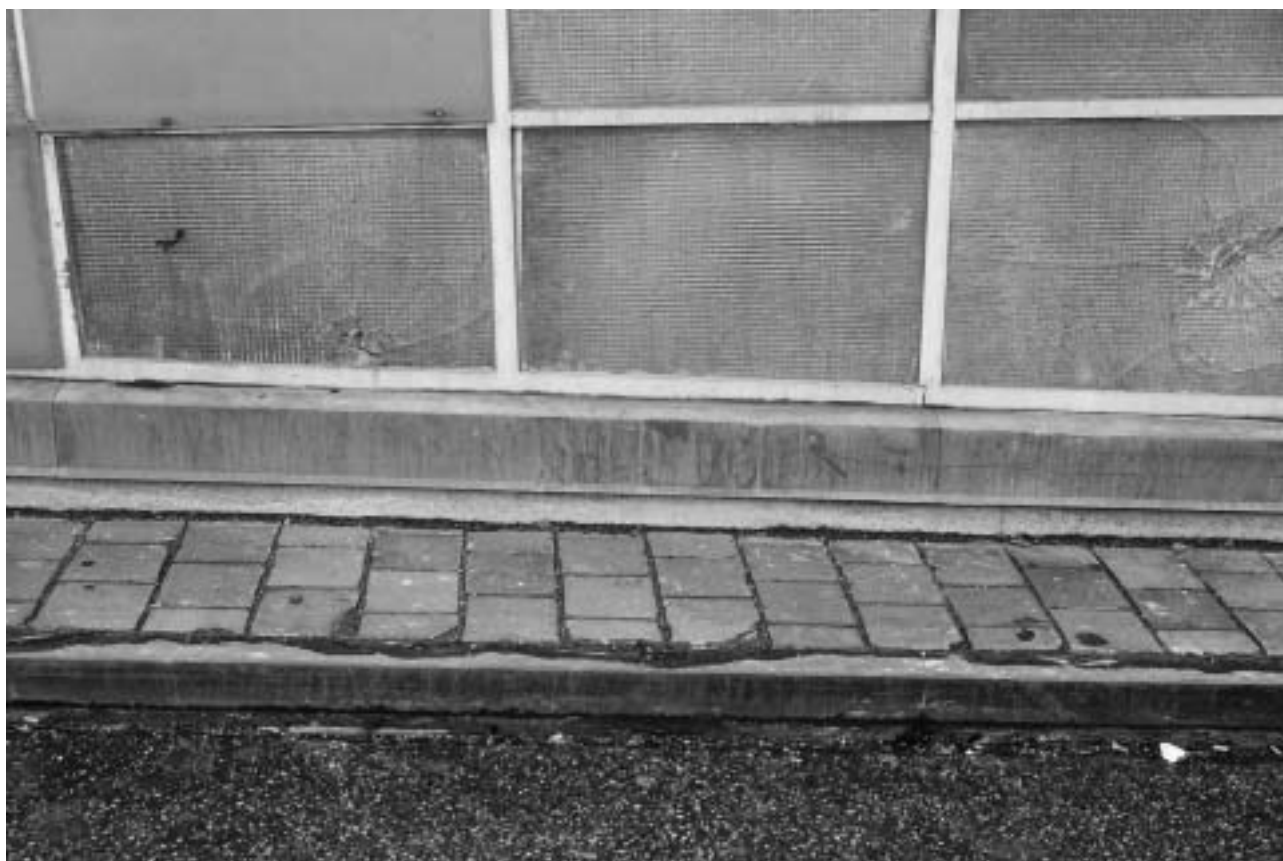
Ursprunglig markbeläggning i rödbrun klinker på Mälarrampens östra trottoar. GF SF05-0007 17A.
