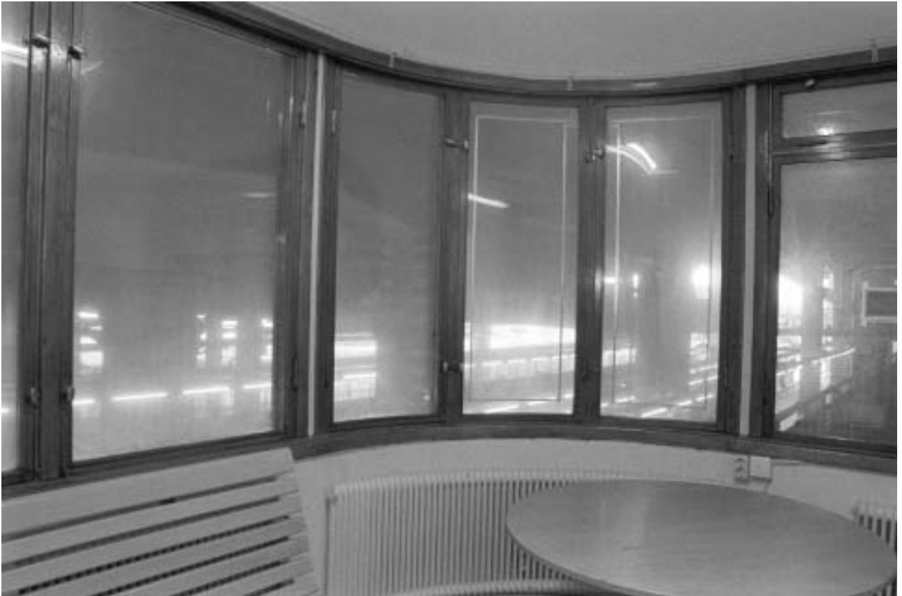
Saltsjöbanans stationshus, interiör från övervåningen. GF S2005-0032-25.
