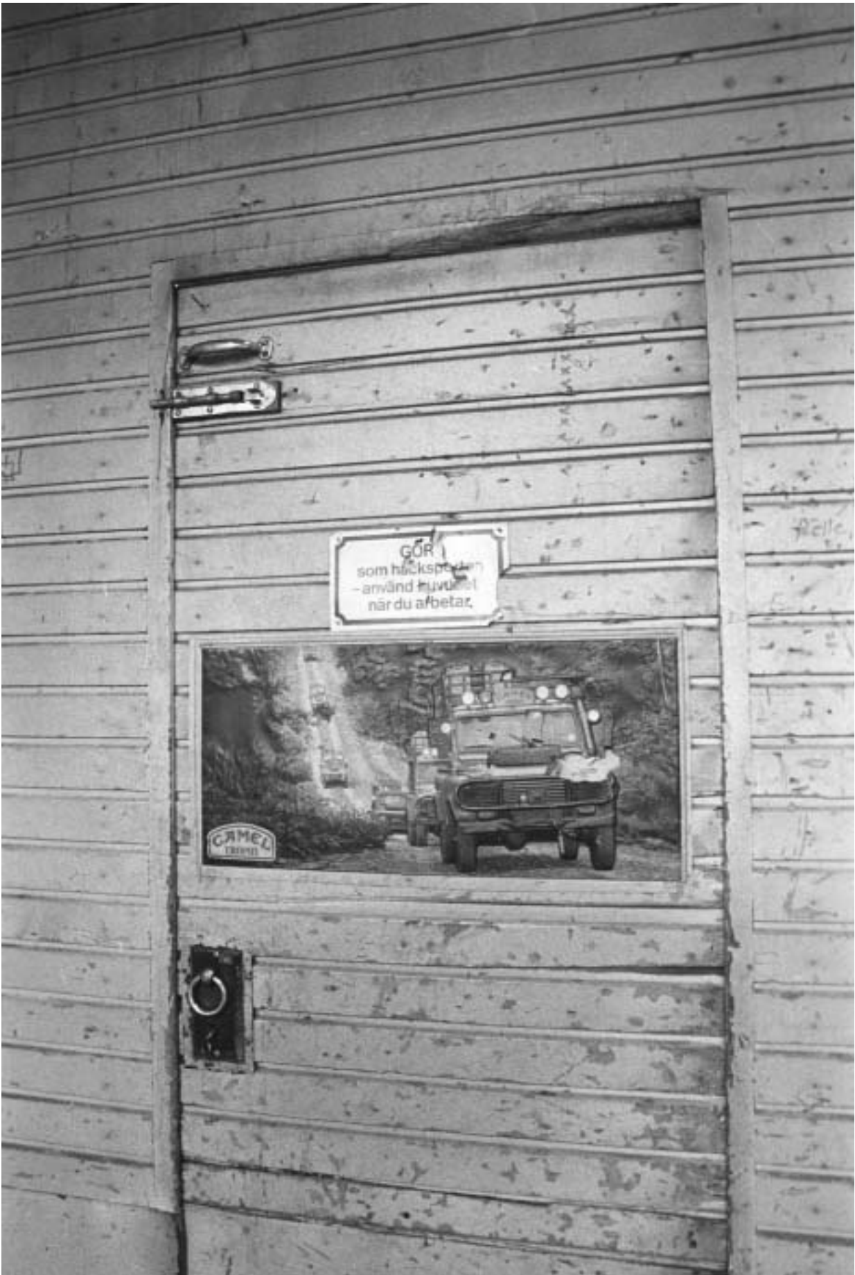
Lokaler under Katarinavägen och Skeppsbron. Skjutport med infälld gångdörr. GF S2005-0039-18A.
