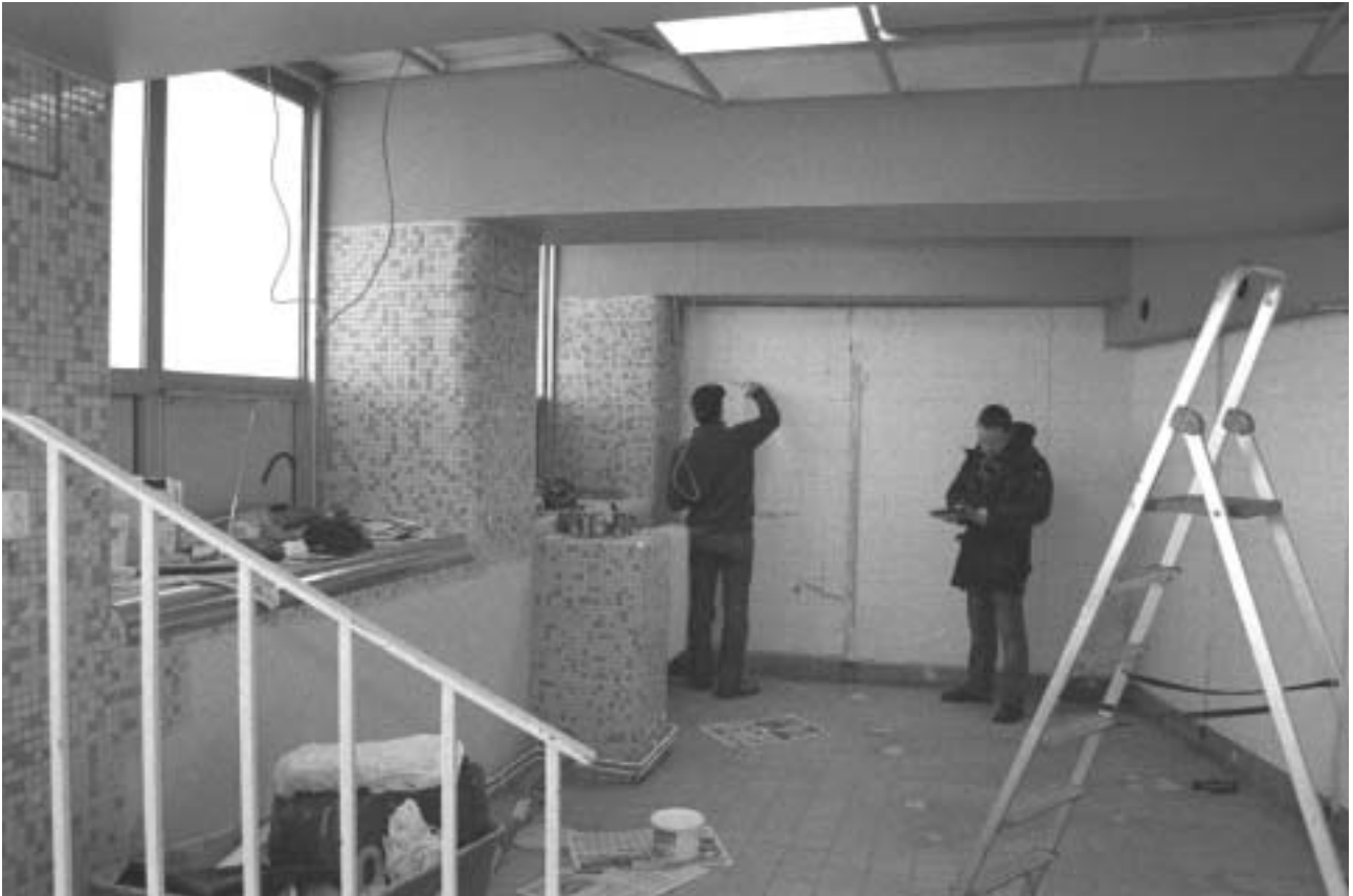
Den före detta offentliga toaletten vid stråkets södra del, under ombyggnad i mars 2005. GF S2005-0036-21A.
