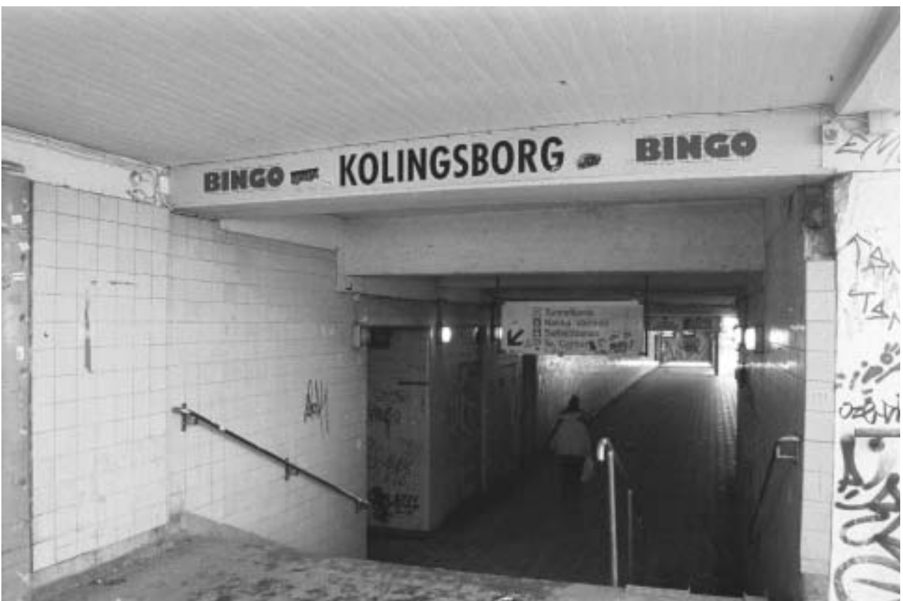
Gångstråket har två inre trappor, detta är den sydligaste. Foto mot norr. Bortom trappan till vänster syns öppningen som leder till trappan ned till Saltjöbanan, bussterminalen och tunnelbanans nedre biljetthall GF S2005-0010-10.
