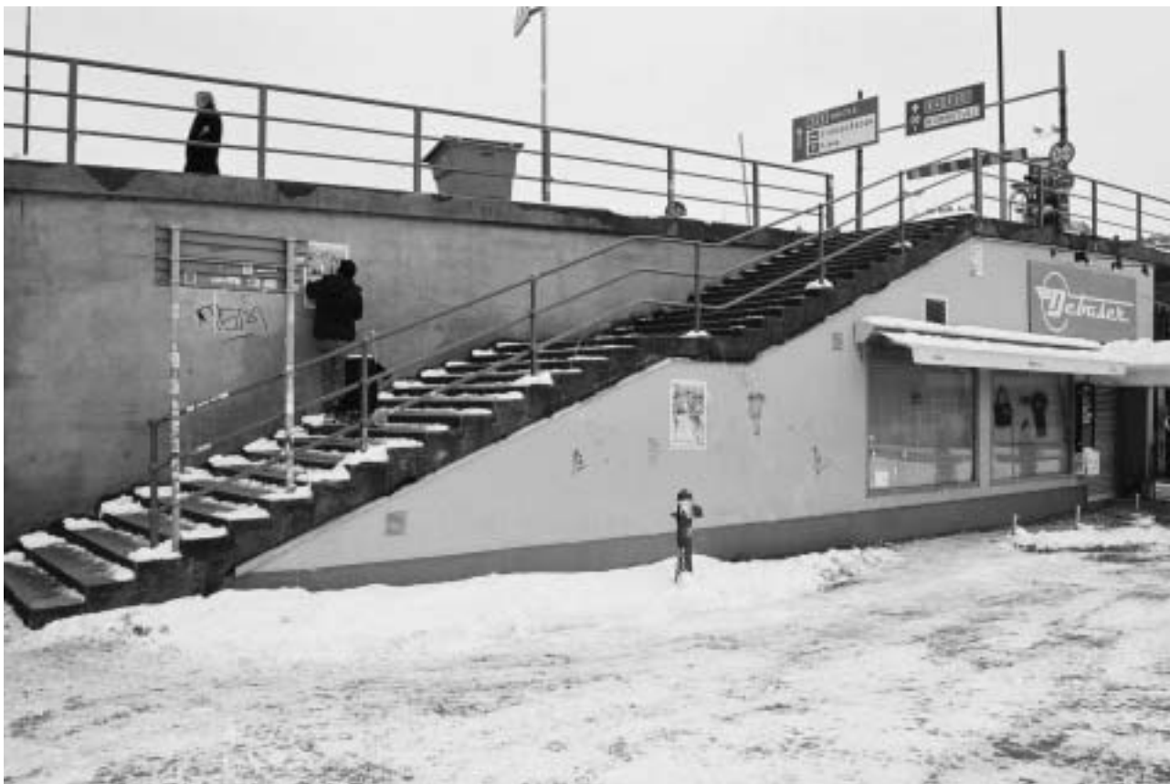
Trappan mellan Karl Johans torg och Skeppsbron, sekundärt underbyggd. GF SF05-0007-07A.
