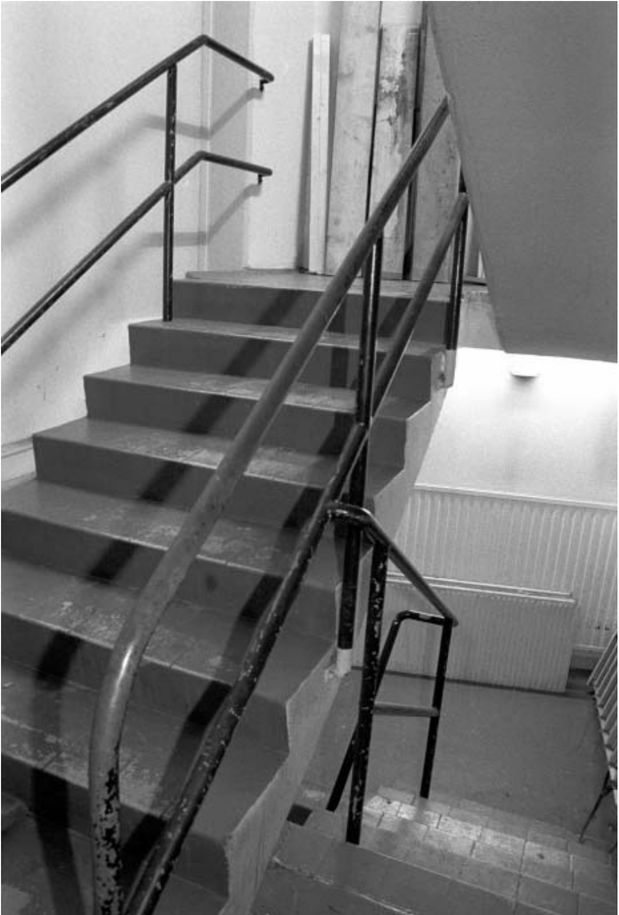
Den sekundära trappan från 1950-talet som binder ihop lokalens tre våningar. GF S2005-0029-22.
