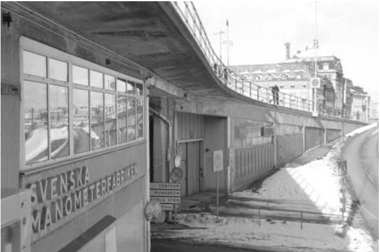
Fasad under Skeppsbron mot väster. Foto från söder. GF S2005-0012-14A.
