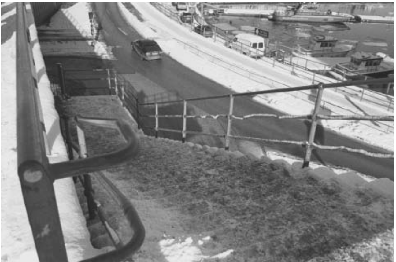
Trappa mellan Östra Slussgatan och trottoaren vid Saltsjörampen, övre trapplopp med ursprungliga räcken. GF S2005-0012-09A.
