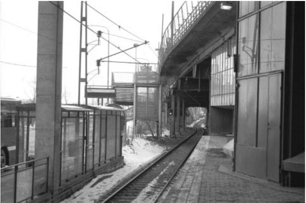
Fasad mot norr. Foto mot öster. Längst mot väster vetter fasaden mot Saltsjöbanans perrong. GF S2005-0033-09.
