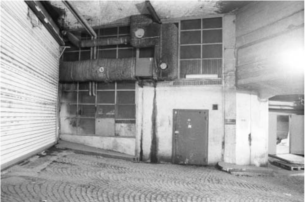
Den västra lastinfarten invid Saltsjöutfarten. Foto mot öster. GF S2005-0021-31.
