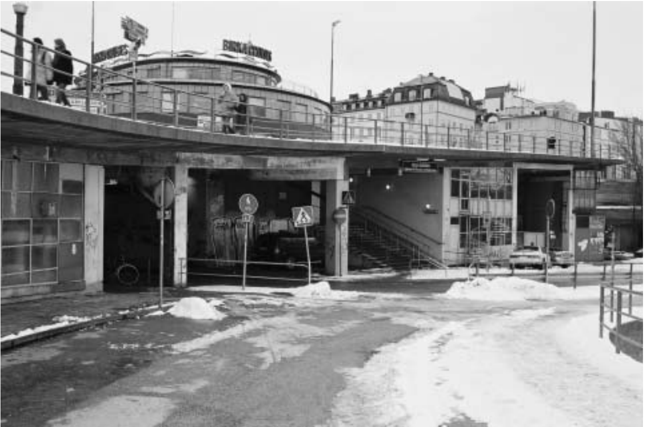
Lokal E, vy av fasaden mot norr med Norra Järngravens mynning till vänster i bild. GF SF05-0007-18A.
