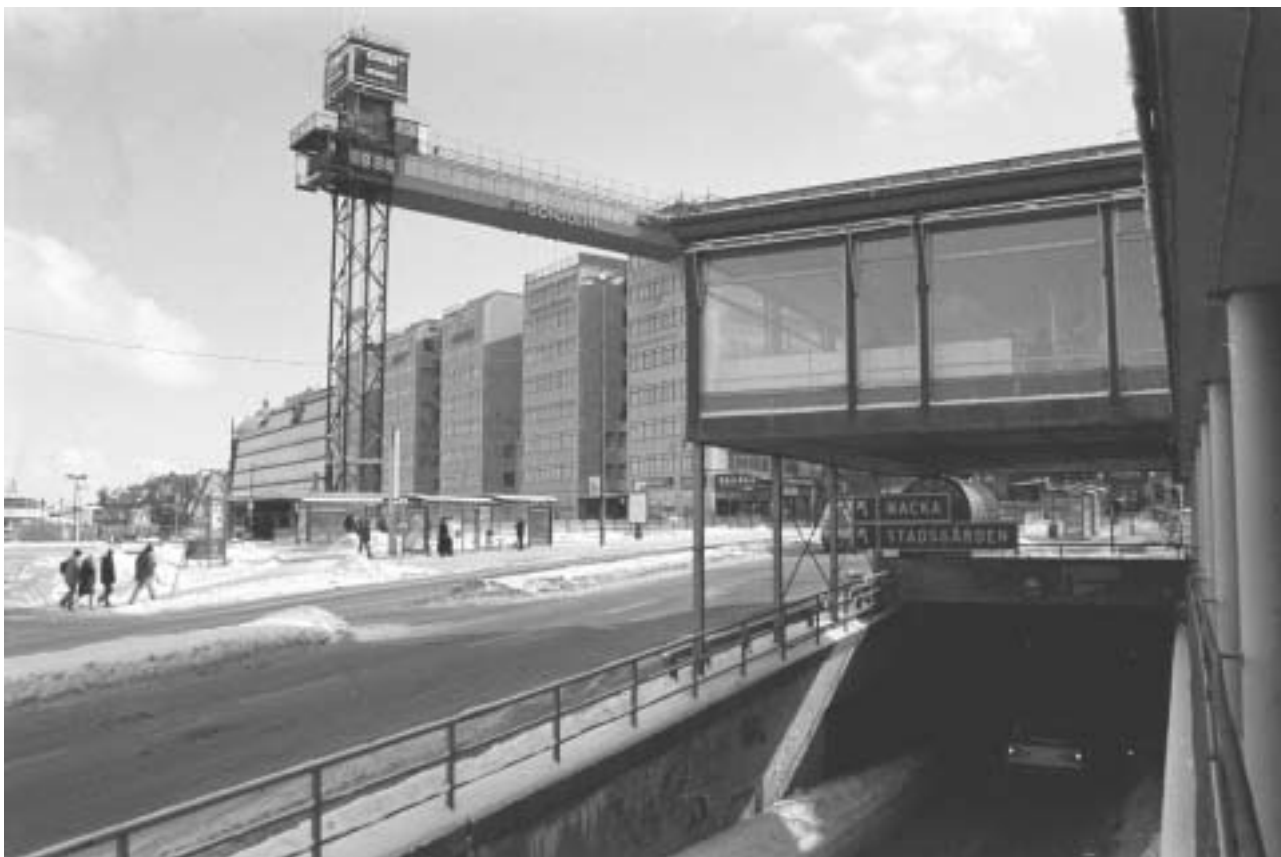
Lokal I, Restaurang Strömmen, fasad mot norr. Byggnaden skjuter ut över Saltsjöutfarten. GF S2005-0010-13.
