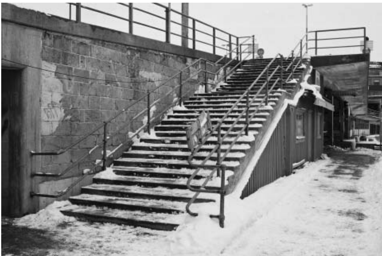
Trappan mellan kaj vid Kornhamn och Katarinavägen. Sekundärt underbyggd. GF SF05-0008-7A.
