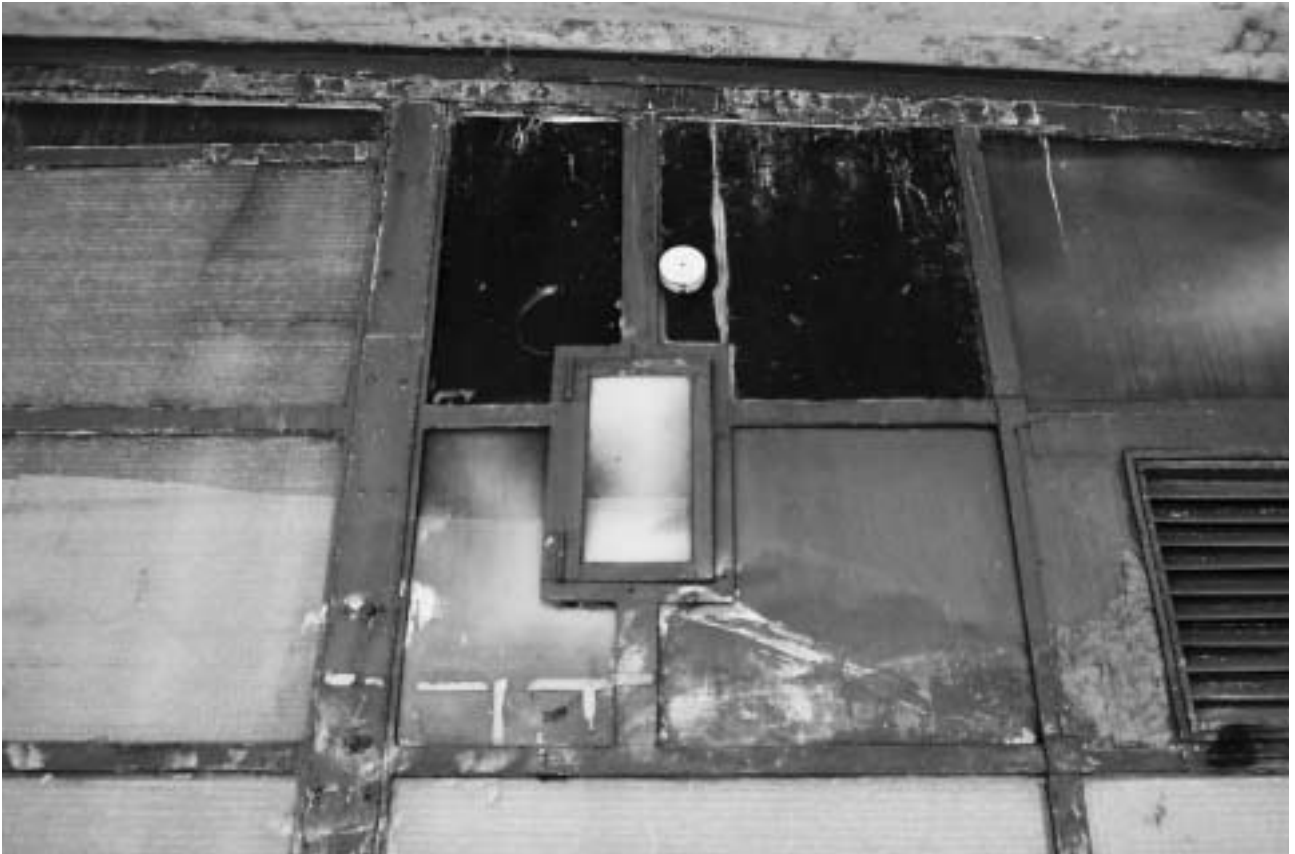
Fasad under Mälarrampen, detalj av stålfönsterparti med vädringslucka. GF SF05-0007-29.A.
