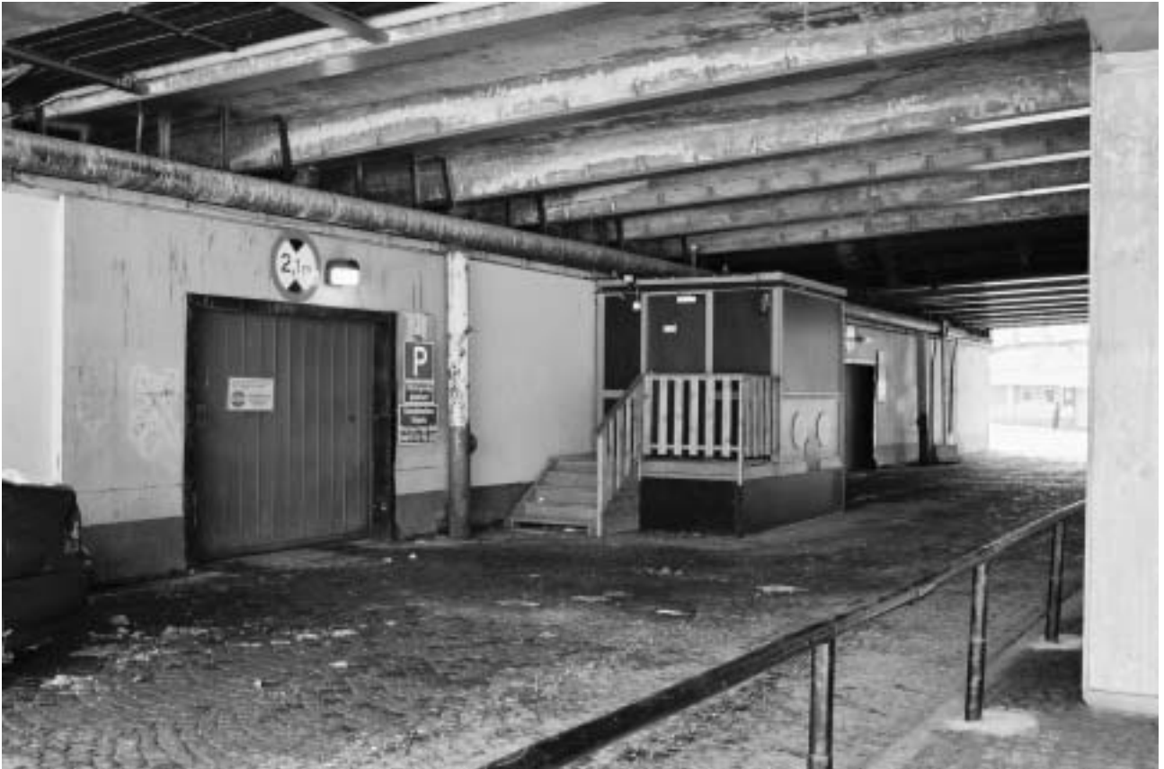
Fasad mot söder. Lokal A bevarar de ursprungliga skjutportarna, men i dessa sitter sekundära infällda garageportar. GF SF05-0008 16A.
