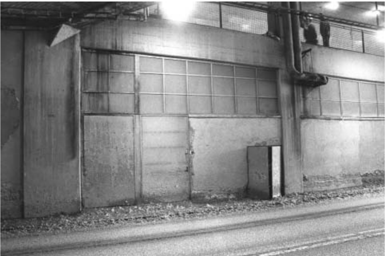
Fasad mot söder, invid Södra Järngraven. GF S2005-0016-27.
