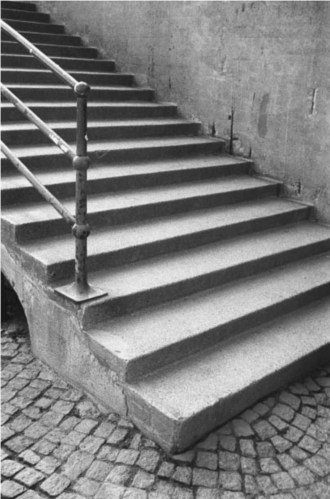
Detalj fotografi av trappa mellan Karl Johans torg och Katarinavägen, ursprungliga räcken. GF S2005-0046-23.
