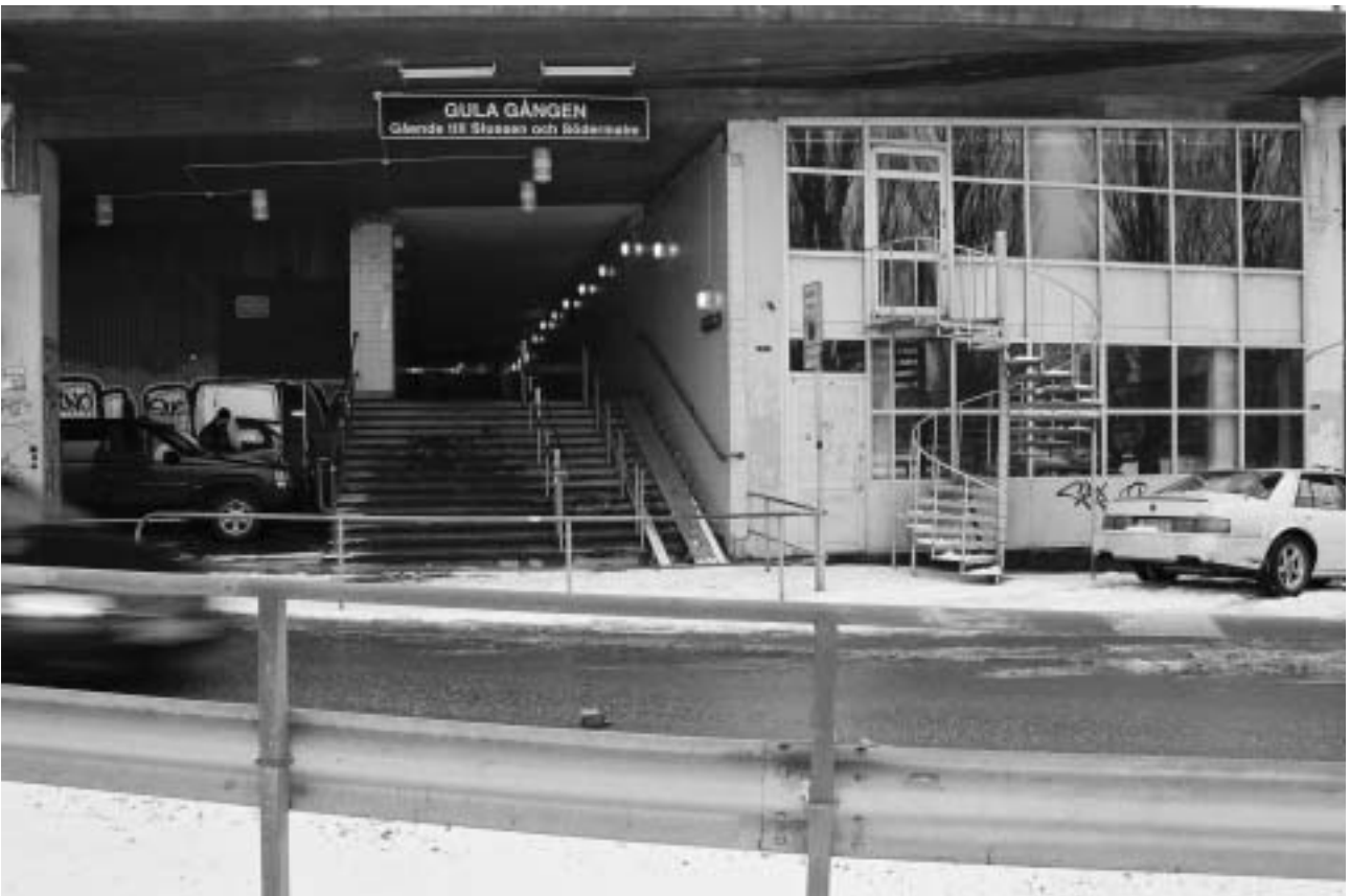
Fasad mot söder, med Gula Gångens norra mynning. GF SF05-0007-21A.
