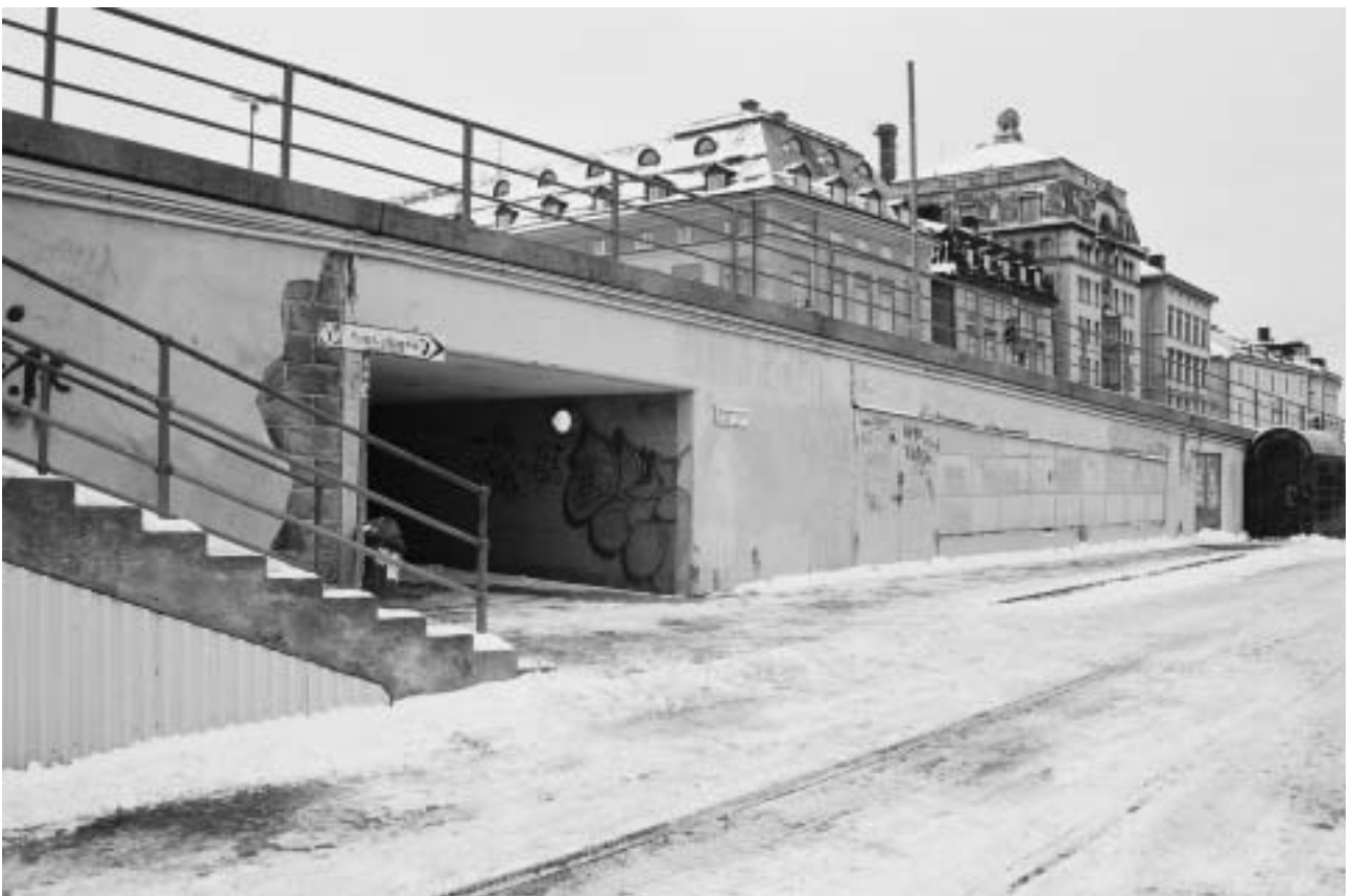
Fasad mot öster, med de idag igensatta fönstren vid förrådslokalerna över avtappningskanalen till höger. GF SF05-0008-36A.
