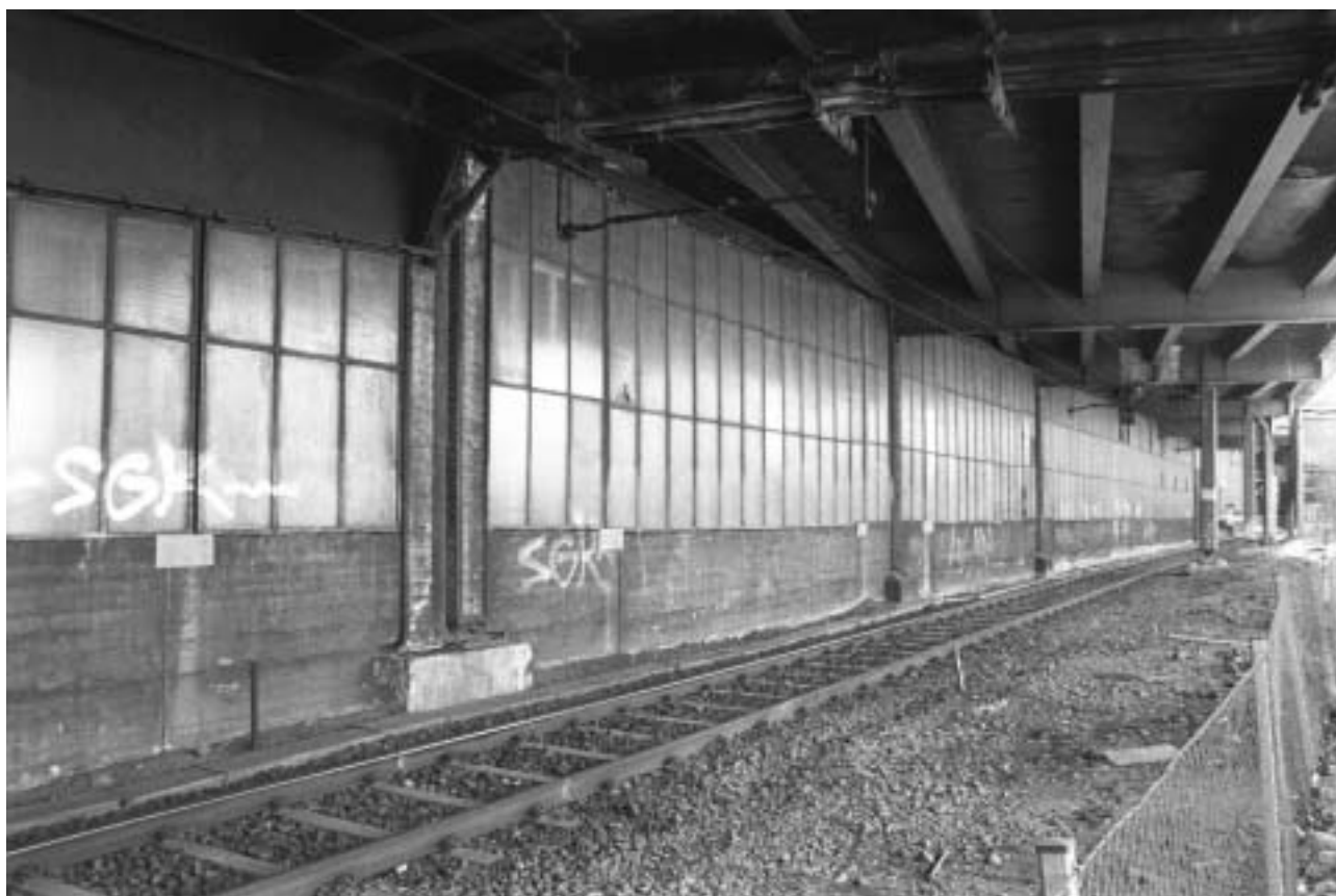
Fasaden mot norr, vid Saltsjöbanans spår. Foto mot väster. GF S2005-0027-08.
