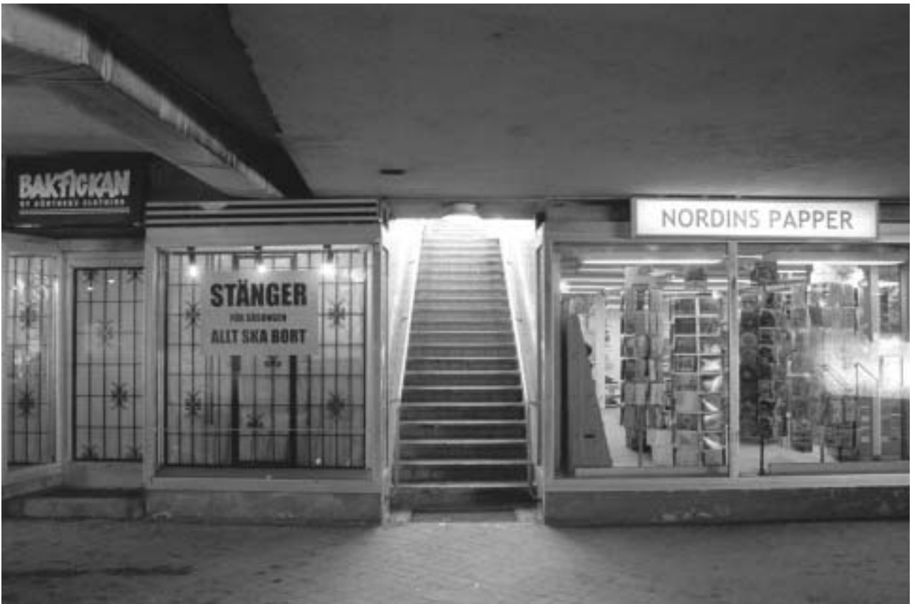
Vid huvudgångstråkets mittparti leder en trappa upp till platsen på Blå Bodarnas tak. GF S2005-0018-23A.
