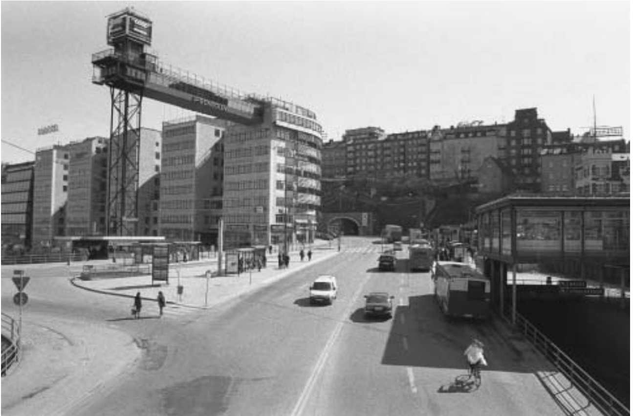
Katarinavägens norra del, mot söder. Södra Slingan till vänster i bild. GF S2005-0047-33A.
