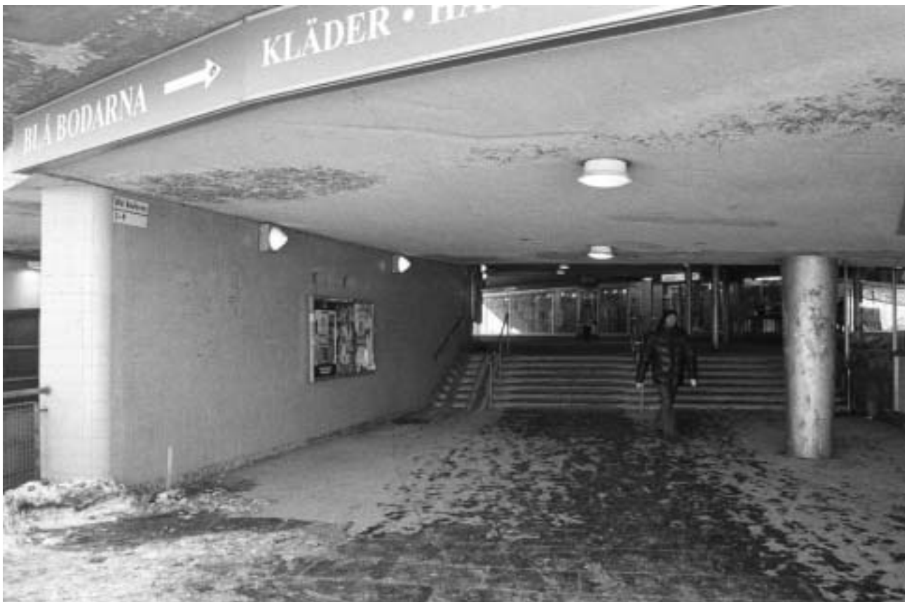
Huvudgångstråkets norra mynning, vid Slussenterrassen. GF S2005-0018-29A.
