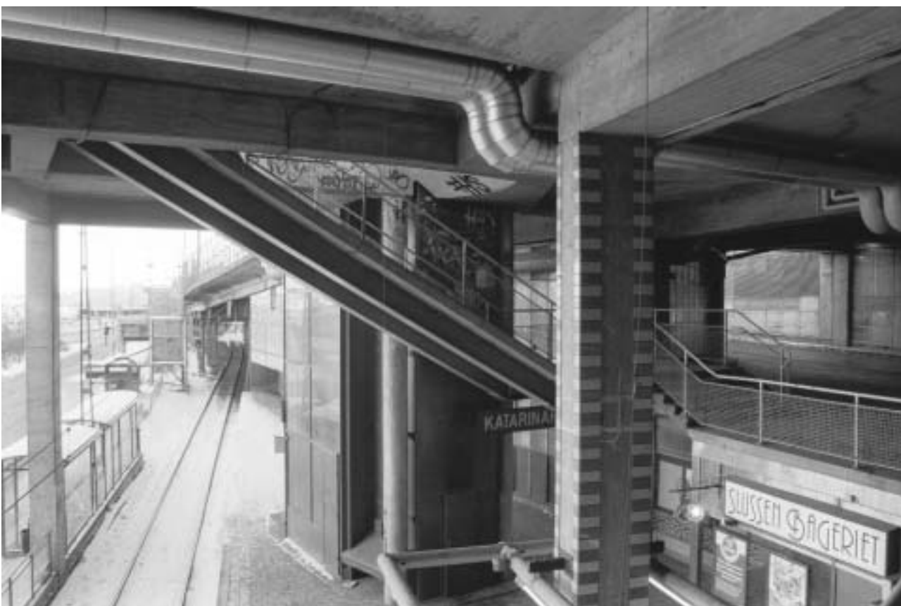
Stationens östra del, med trappan upp till Östra Slussgatan i förgrunden. GF S2005-0020-33A.
