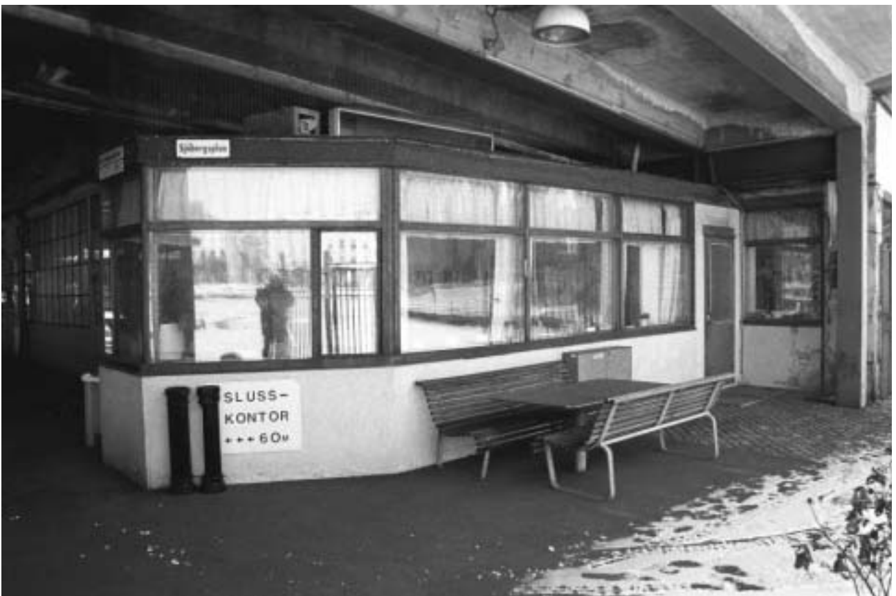
Fasad under Katarinavägen och Skeppsbron mot norr. F.d. Slusskontor. GF S2005-0017-21.
