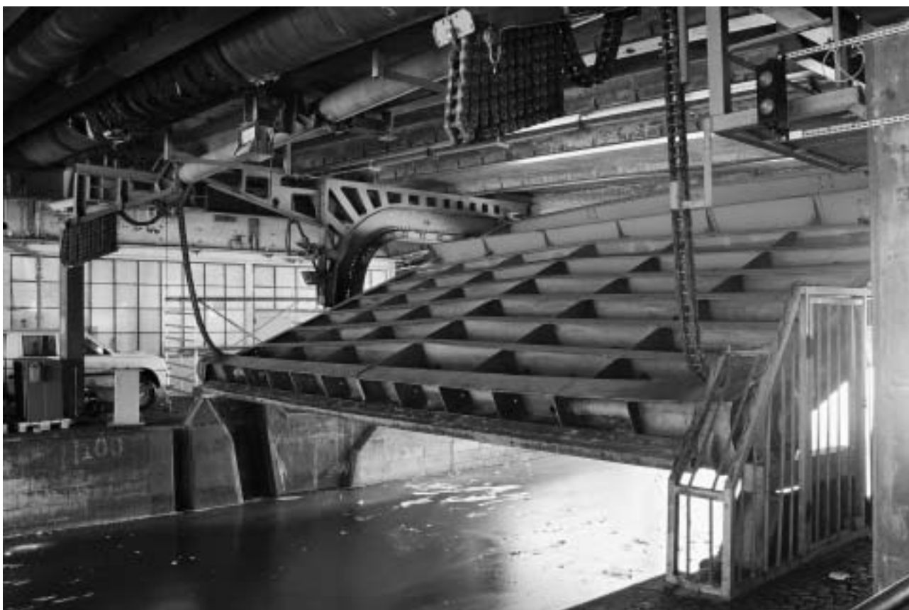
Karl Johanslussens västra slussport. GF SF05-0008-20A.
