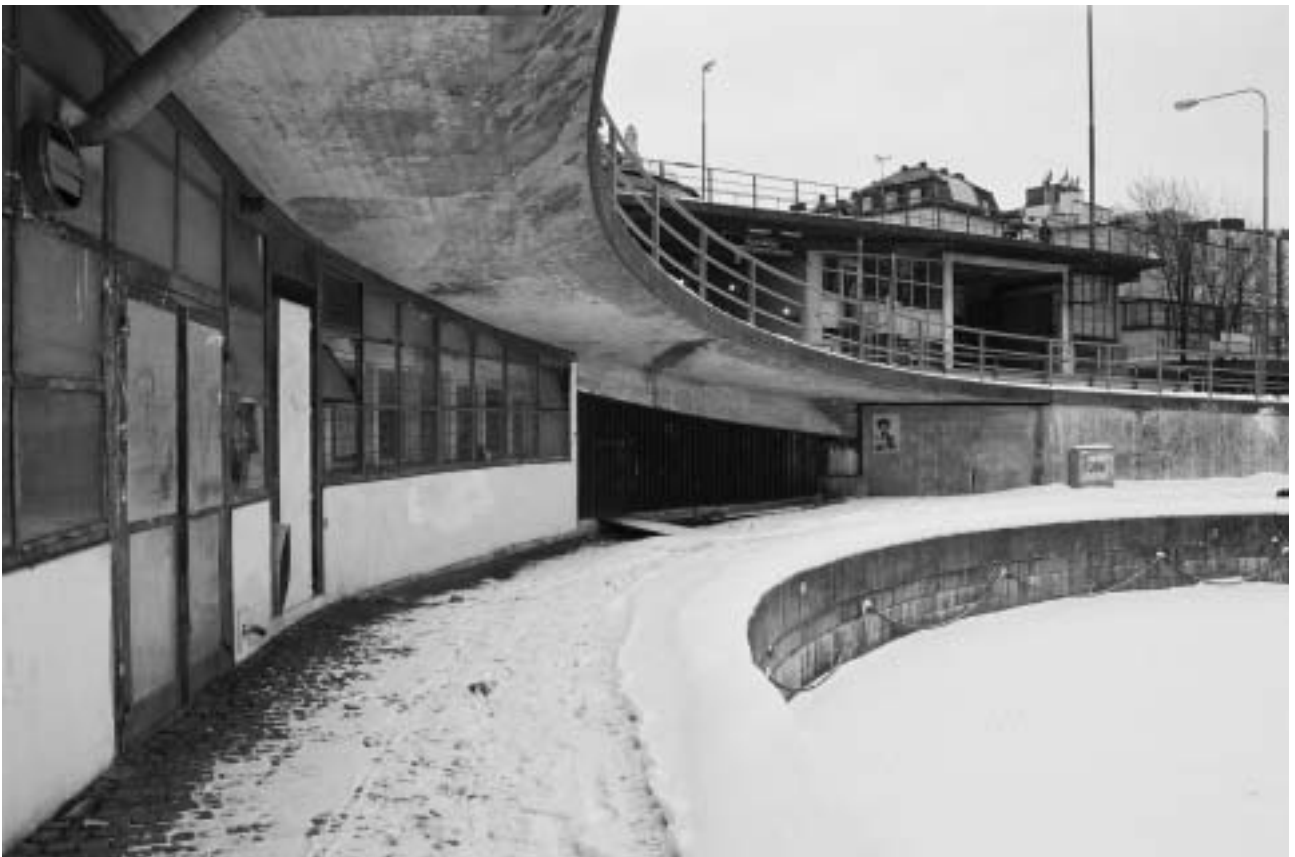
Fasad under Mälarrampen, foto från norr. GF SF05-0007-27A.
