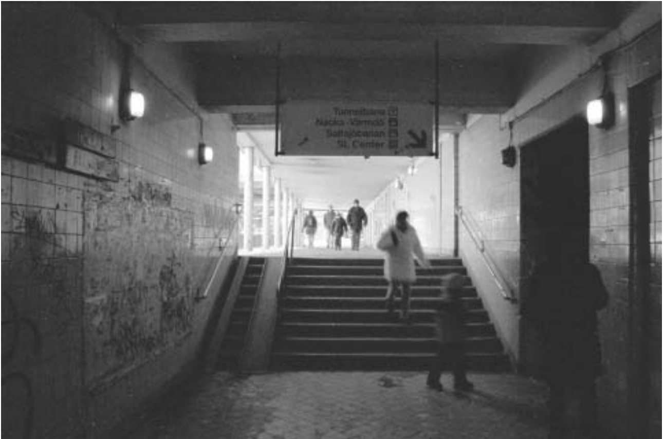
Gula Gångens sydliga inre trappa, mot söder. Närmast kameran till höger en av nischerna som ursprungligen var öppningar till sidospåret mot Saltjöbanan och Södermalmstorg. GF S2005-0010-19.
