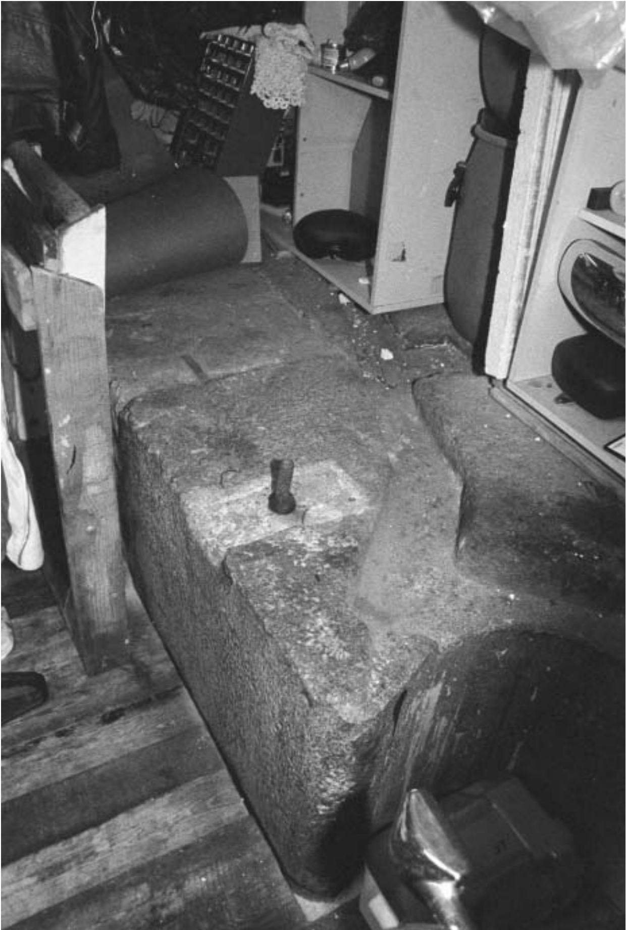
Lokal C, närbild på murpartiet från Polhemsslussen, med urtag för slussportarna. GF S2005-0035-33A.
