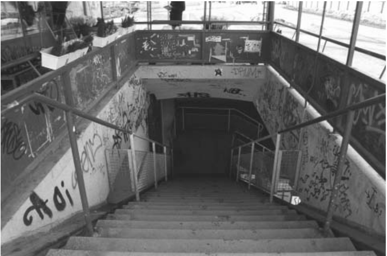
Trappan från Saltsjöbanans stationsanläggning, uppgången till markplanet. GF S2005-0034-26A.
