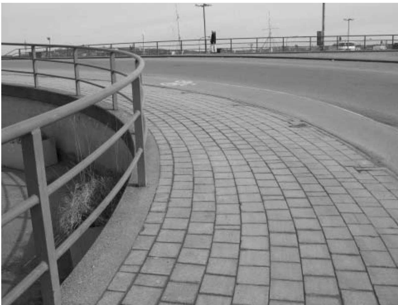
Södra Slingan, den inre trottoaren mot norr, med ursprunglig markbeläggning i rödbrun klinker. SMF, KMA, oregistrerat fotografi.
