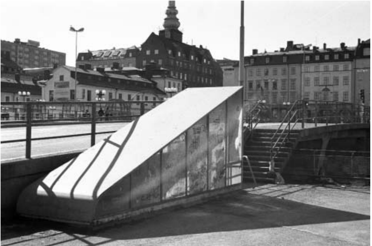
Över trappan till taket finns detta funktionalistiskt utformade tak i plåt och glas. GF S2005-0040-15A.
