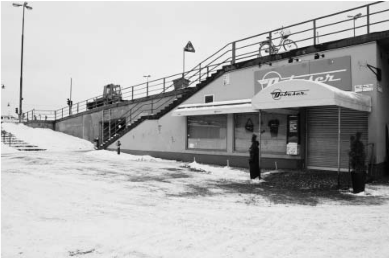
Lokal B, fasad mot väster. GF SF05-0008-28A.
