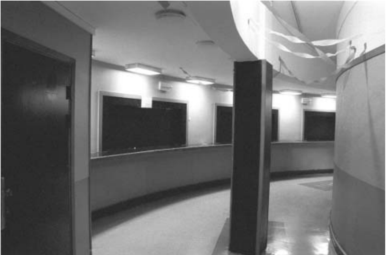
Plan 1, den sydligaste delen, vid de ursprungliga avlöningskassorna, som har plan 2 som tak. Väggen till höger, mot utropshallen, är sekundär. GF S2005-0030-35.
