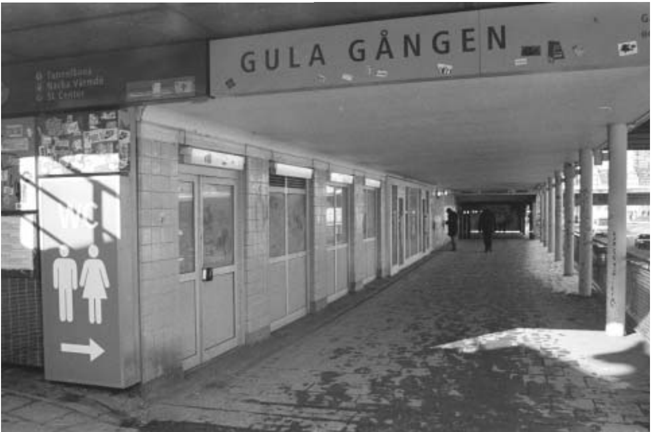
Lokal K, Gula Gångens södra mynning. Foto mot norr. GF S2005-0010-05.
