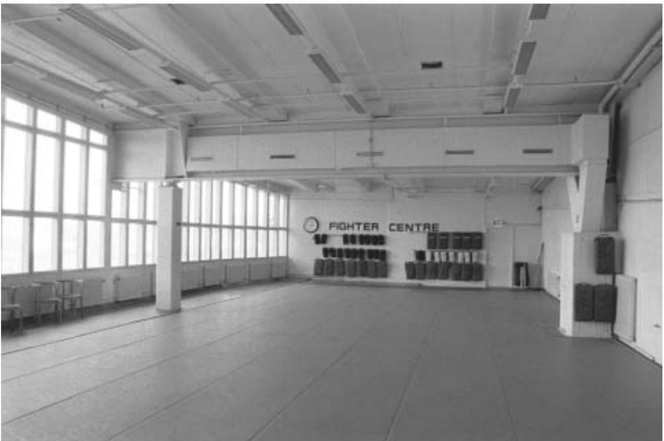
Plan 2. I våningsplanets utrymmen norr om Saltsjöutfarten finns stora stålbalkar i taket, och fönsterpartier mot norr. Foto mot öster. GF S2005-0027-15.
