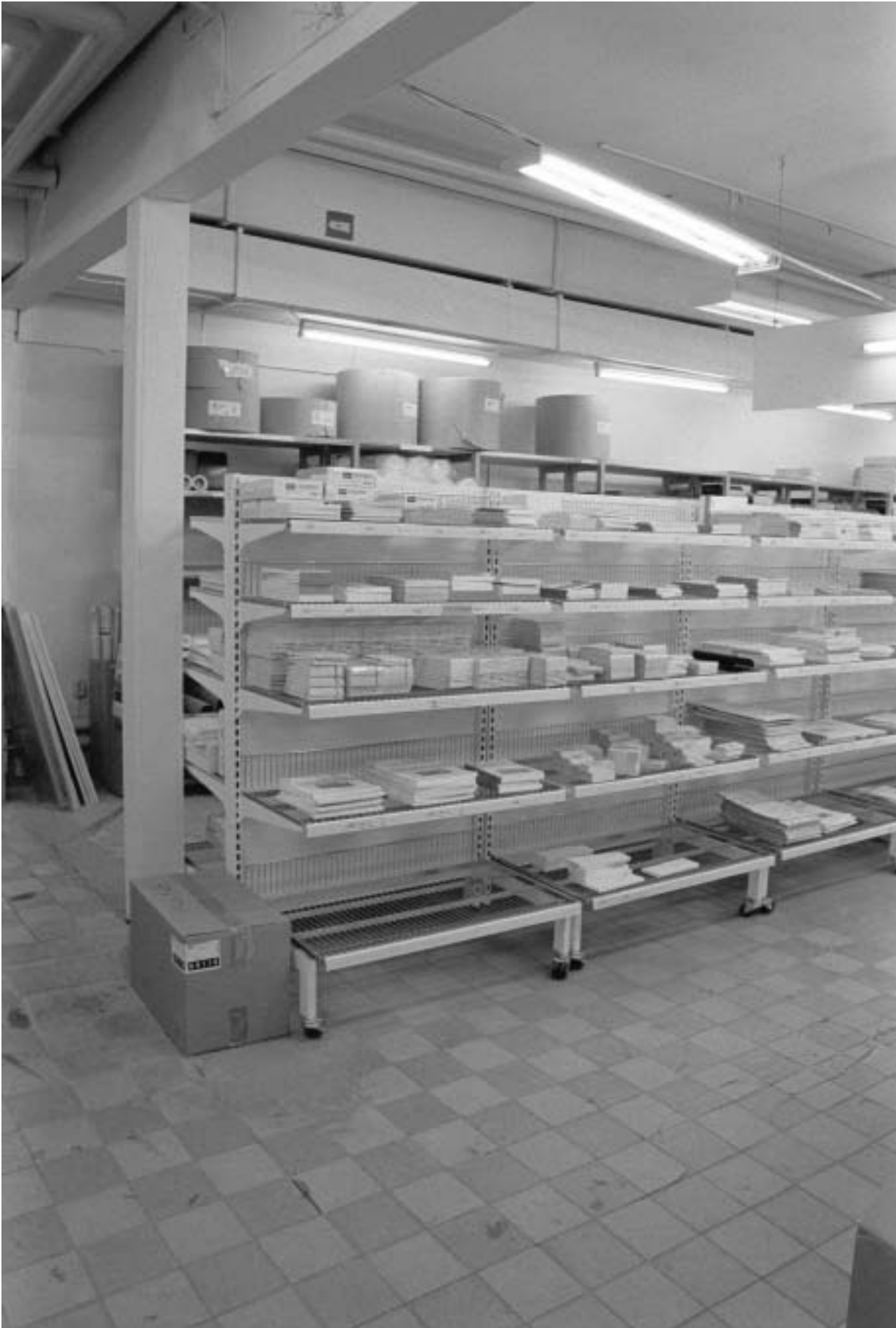
If.d. Åhlén & Holms lokaler (idag en pappershandel) finns ett bevarat, sannolikt ursprungligt, golvparti i cementmosaikklinter. GF S2005-0020-05A.
