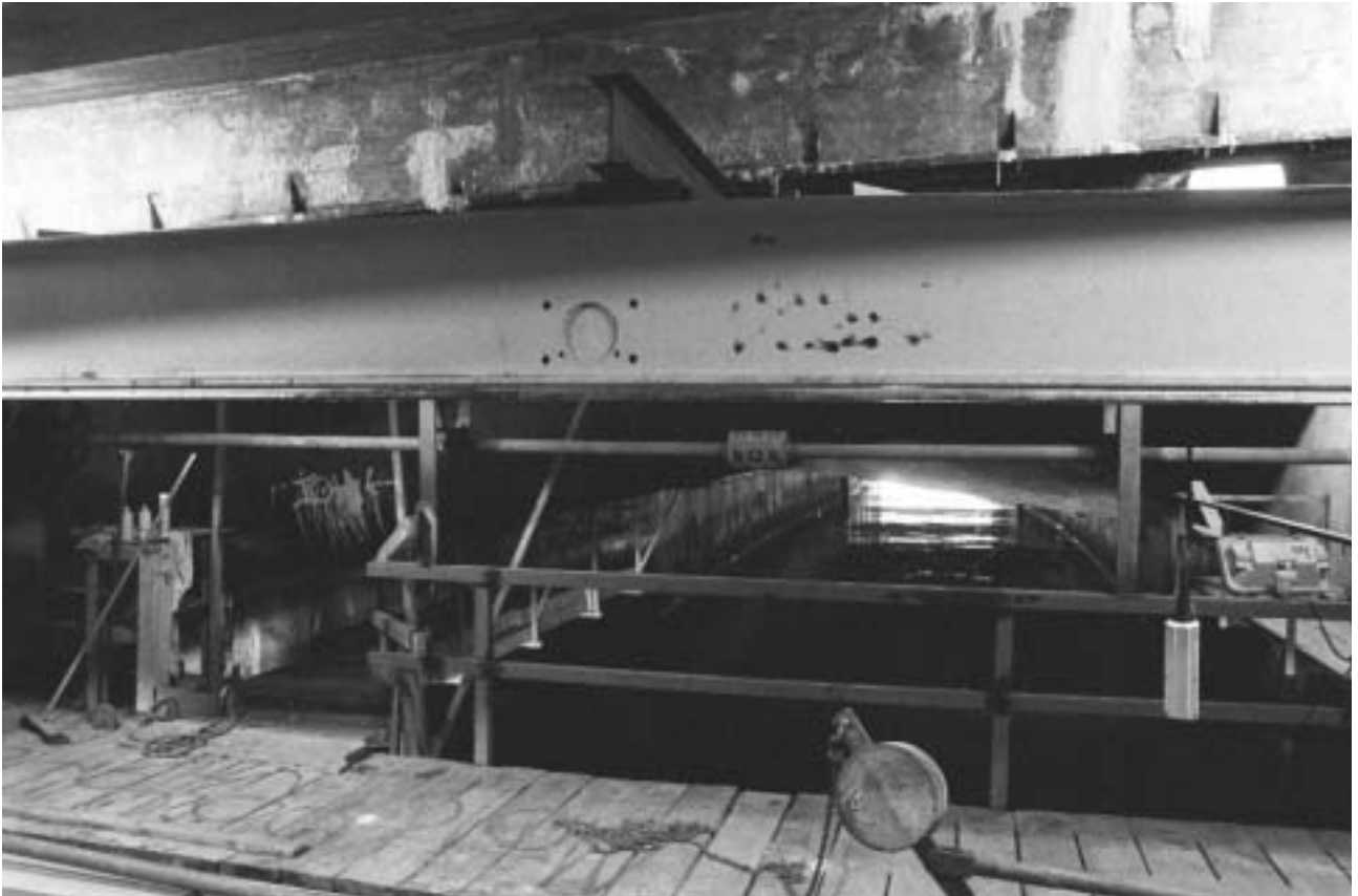
Avtappningskanalens västra del är överdäckt med ett träbjälklag varifrån maskineriet sköts. GF S2005-0034-03A.
