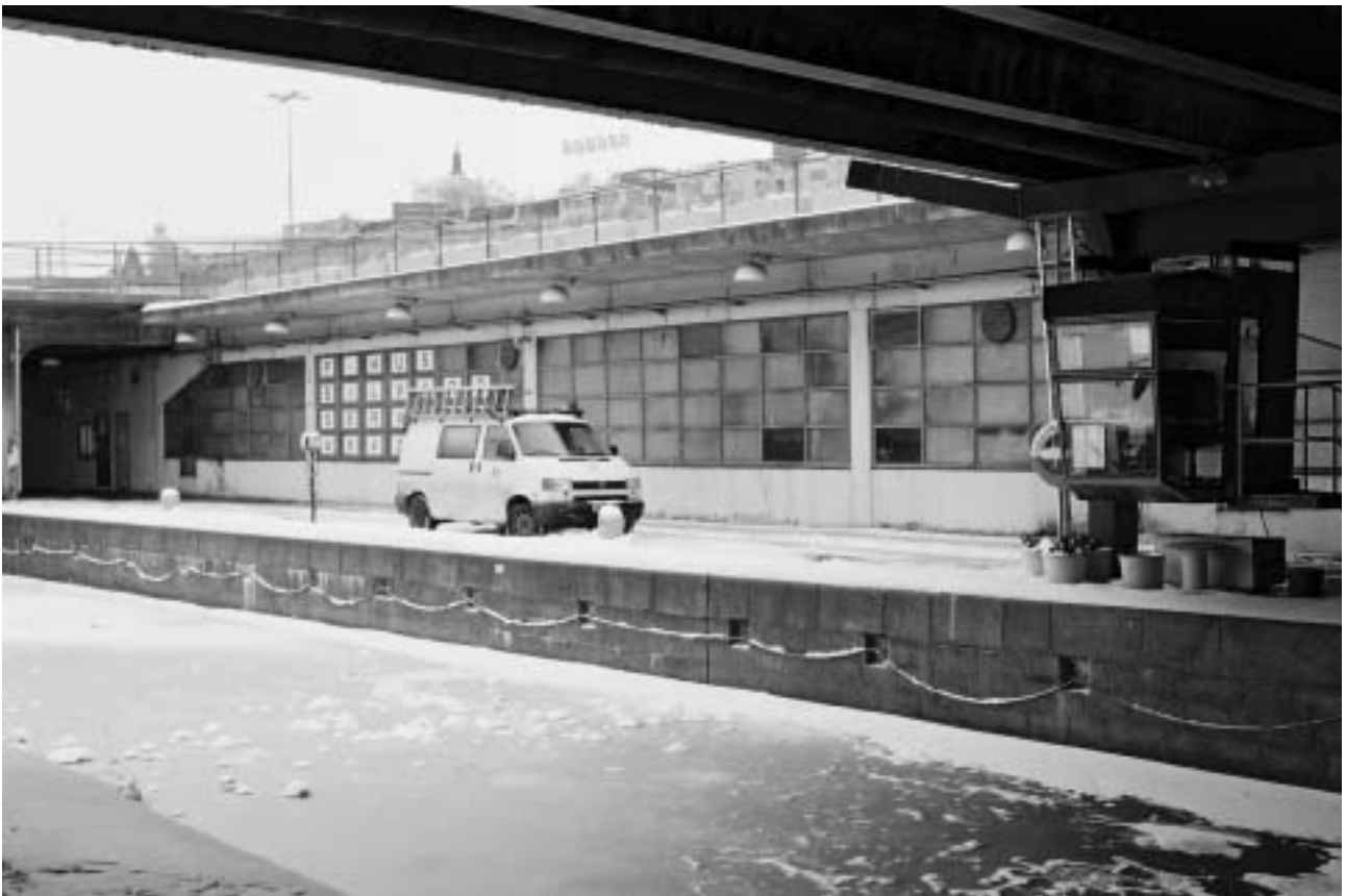
Fasad under Katarinavägen och Skeppsbron. Mittpartiet vid Slussgaraget, från norr. GF SF05-0008-22A.
