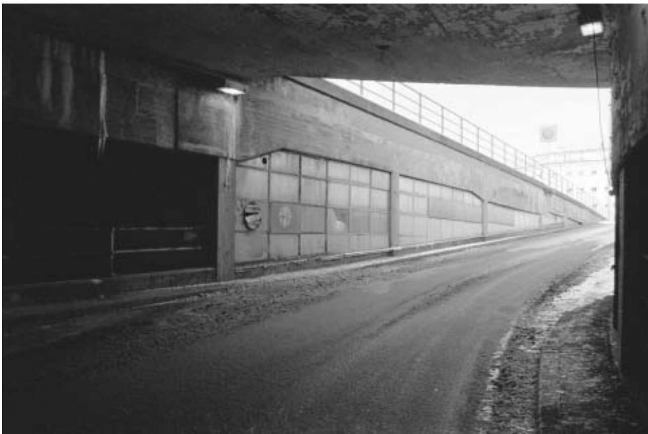
Västra Terrassrampen mot norr. GF S2005-0011-07.
