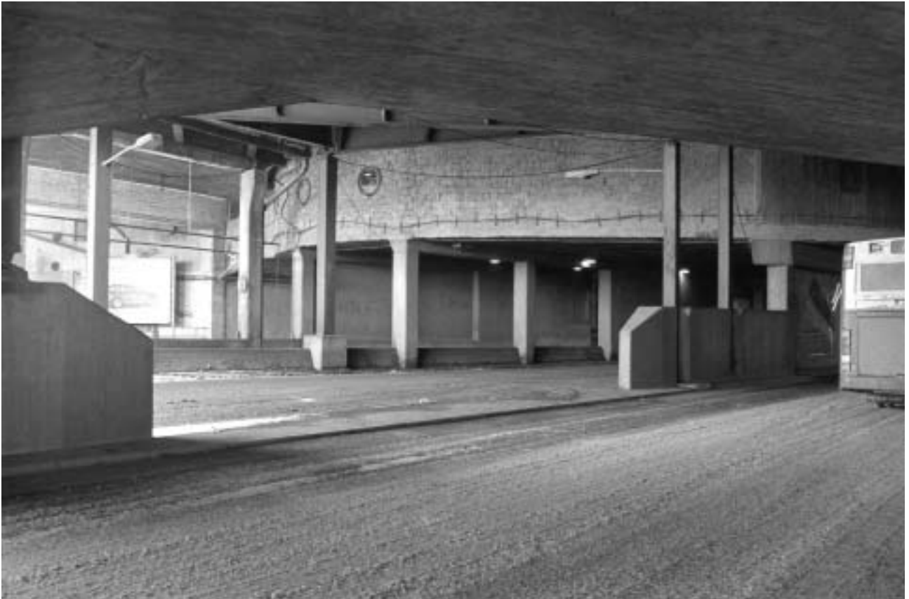
Byggnadens nedre våning är synlig från Södra Järngraven och bussterminalen. Foto från sydväst. GF S2005-0015-01A.
