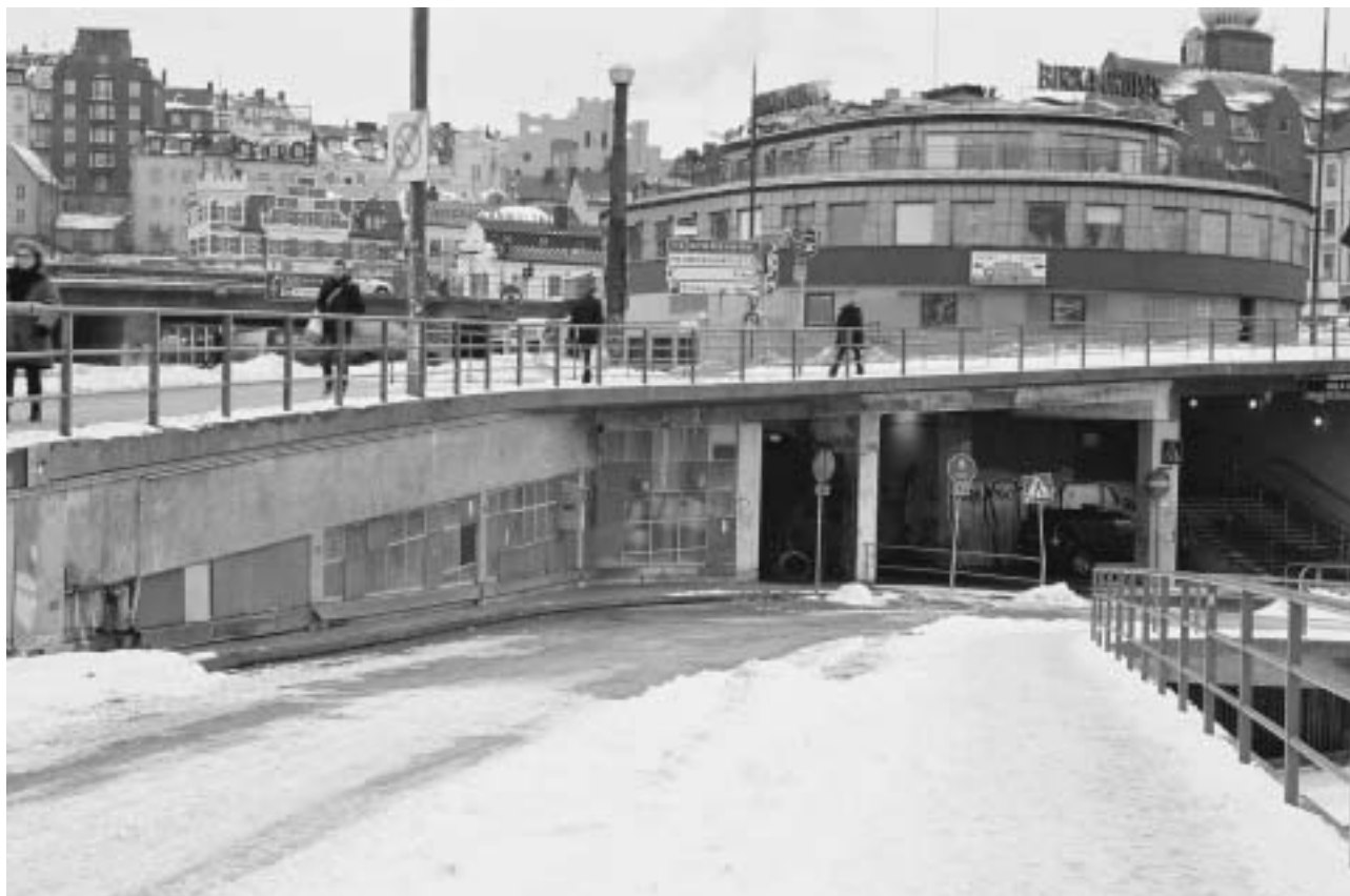
Mälarrampen, mot norr med Västra Slingan i fonden. GF SF05-0007 14A.
