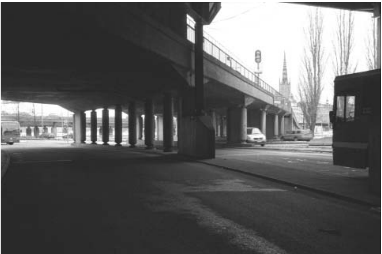
I den västra delen av bussterminalen löper tunnelbanebron mot norr. GF S2005-0032-10.
