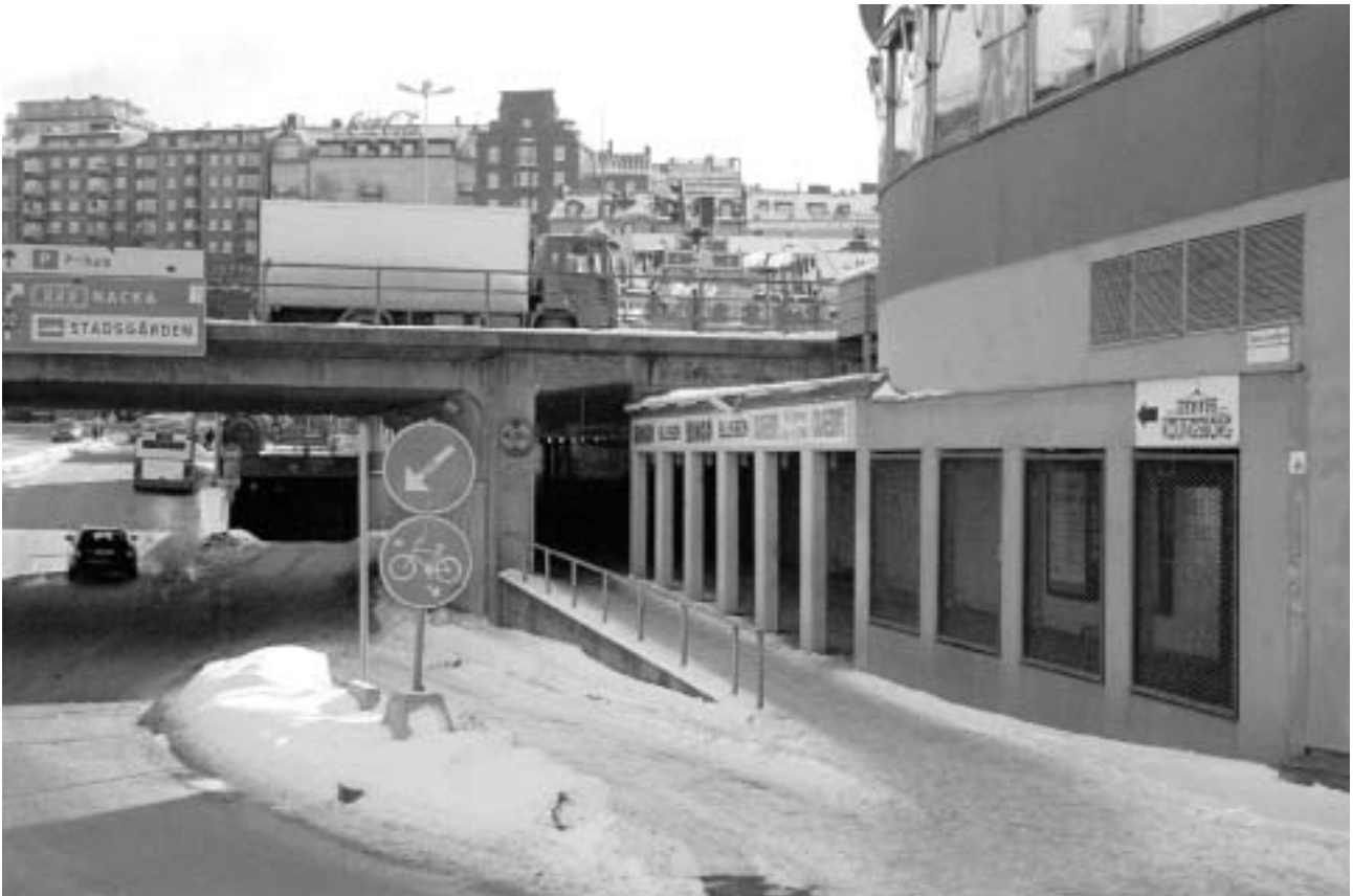
Gula Gången från norr, sträckningen under Kolingsborg. I muröppningarna fanns ursprungligen fönster. GF S2005-0010-27.
