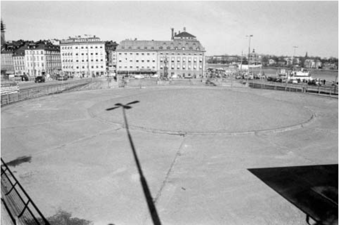
Platsen på Blå Bodarnas tak, glasbetongkupolen övertäckt med asfalt. GF S2005-0040-06A.
