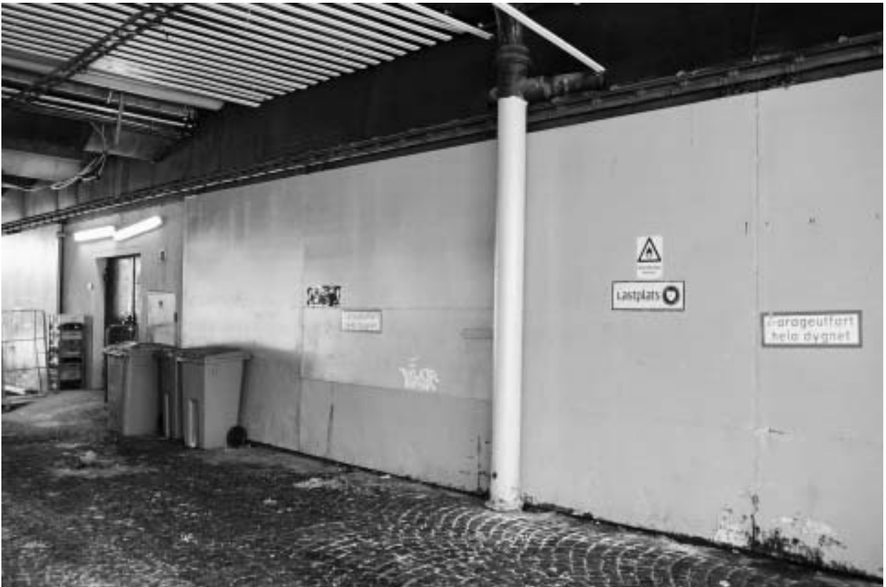
Lokal B, fasad mot söder. GF SF05-0008-32A.
