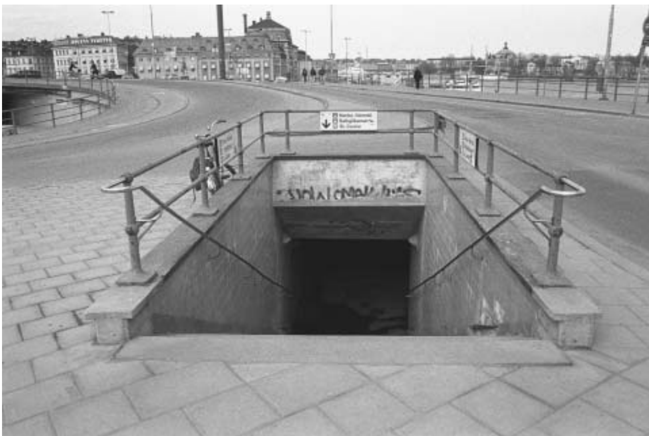
Vid Östra Slussgatan finns en trappa ned till Blå Bodarnas södra sidogångstråk. Ursprungligt räcke och ursprunglig skifferbeklädad på muren. GF S2005-0046-03.
