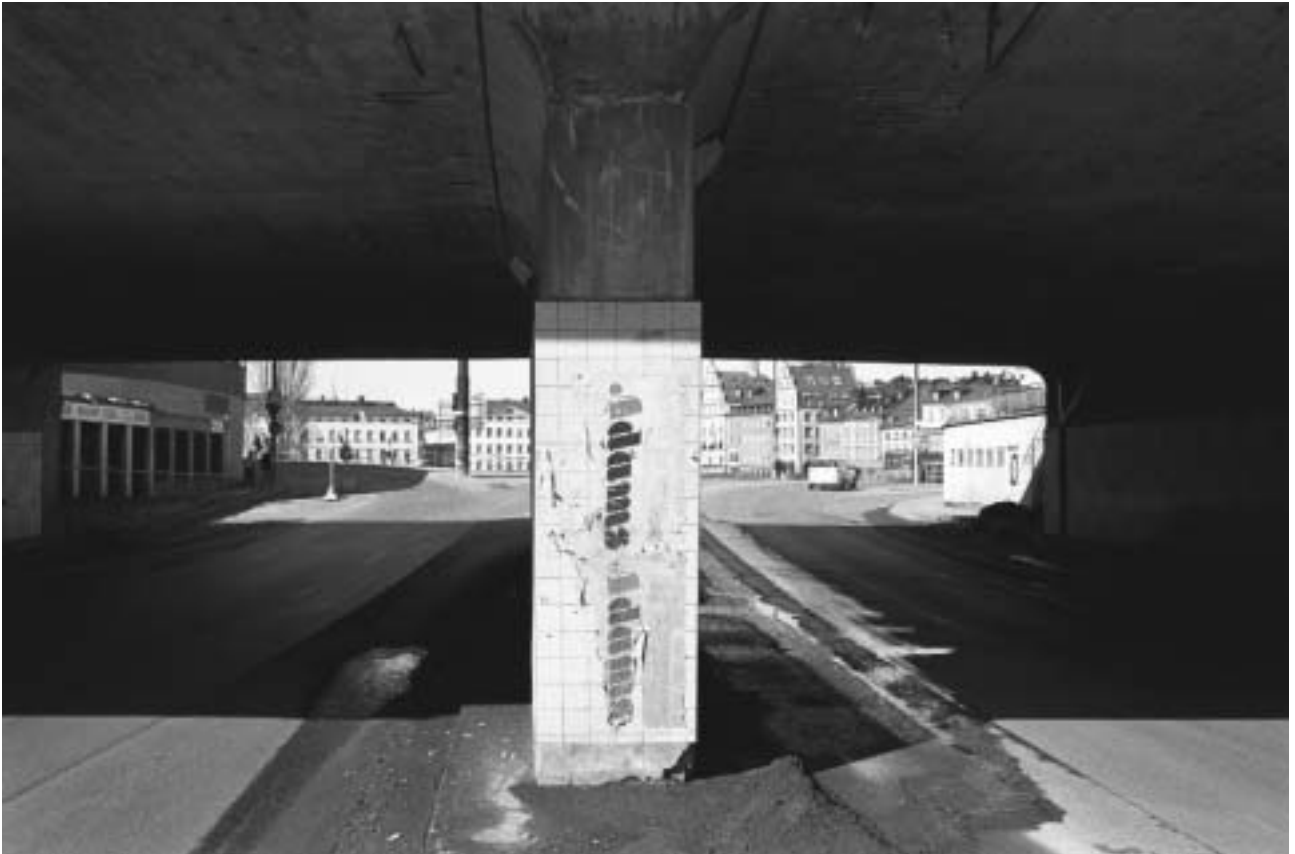
"Dubbelviadukten", Katarinavägens korsning med Skeppsbron, från söder. Kakelbeklädningen på betongväggarna är sekundär. GF S2005-0041-34A.
