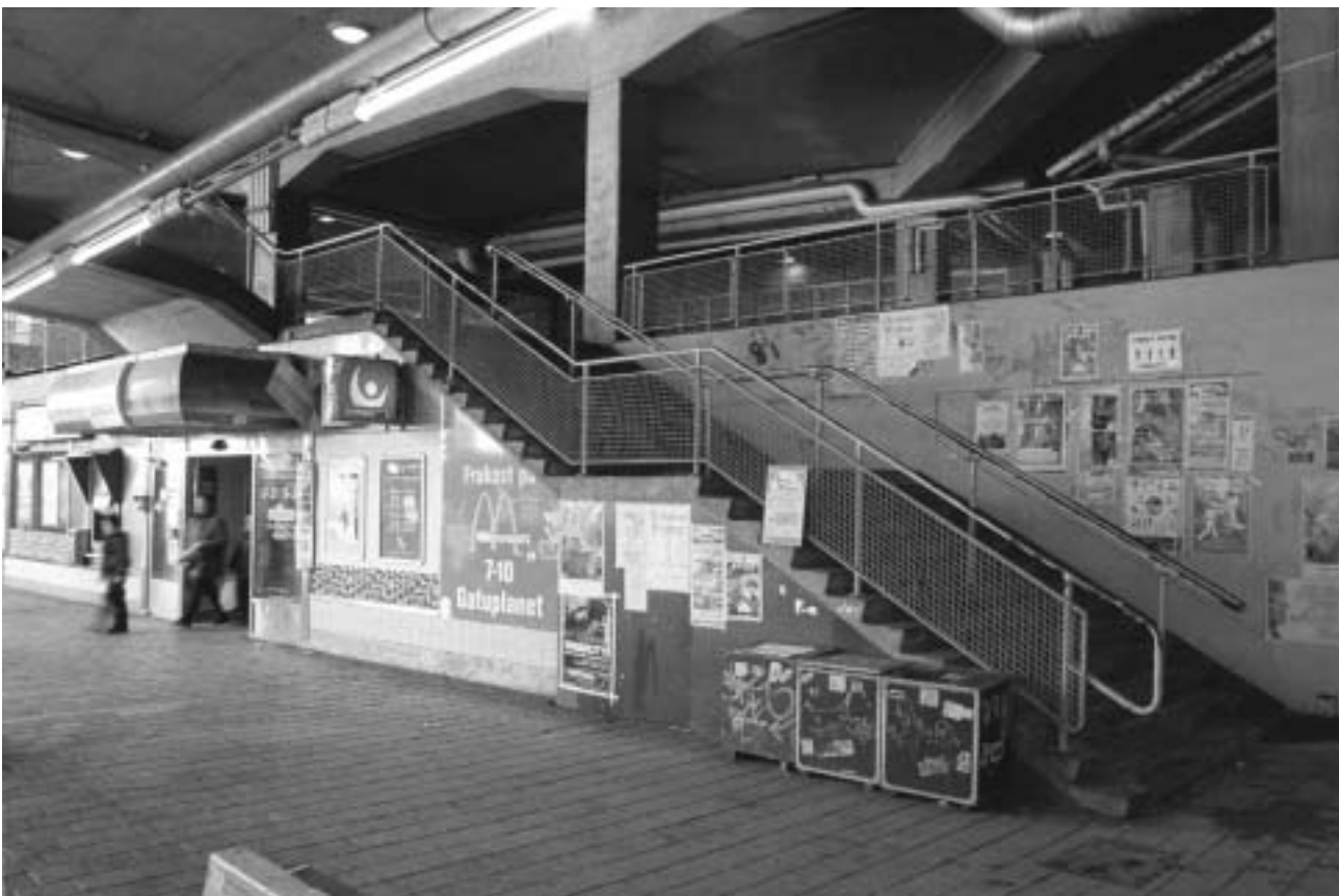
Trappan till markplanet vid Östra Slussgatan, det nedre trapploppet vid stationshusets fasad. GF S2005-0015-18A.
