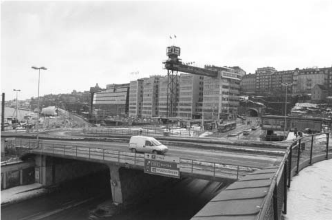
Skeppsbron mittled inom anläggningen, viadukt korsningen med Katarinavägen. GF S2005-0028-28.
