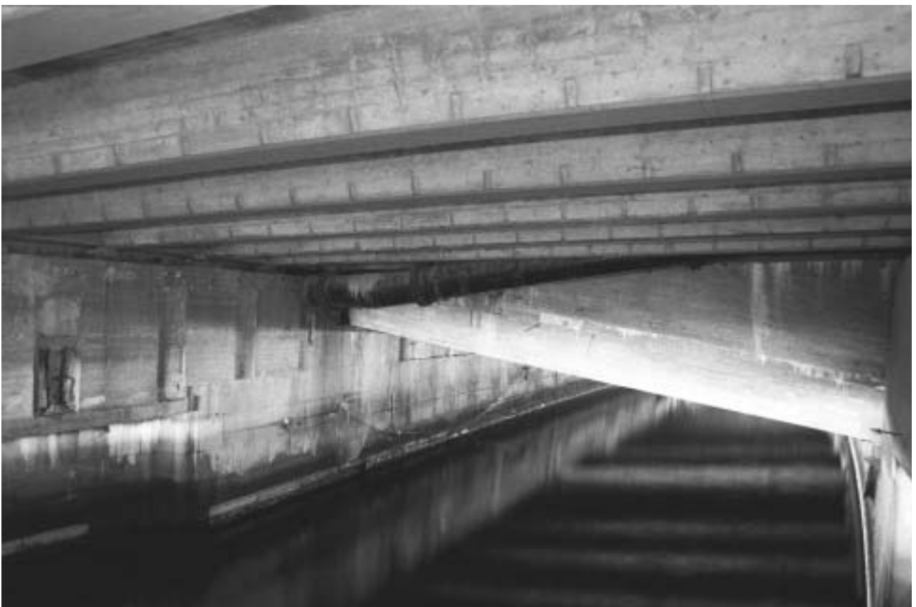
Avtappningskanalen sidor utgörs av den f.d. Nils Ericsonsslussens murverk. Överdäckningen i betong tillkom på 1930-talet. GF S2005-0034-08A.
