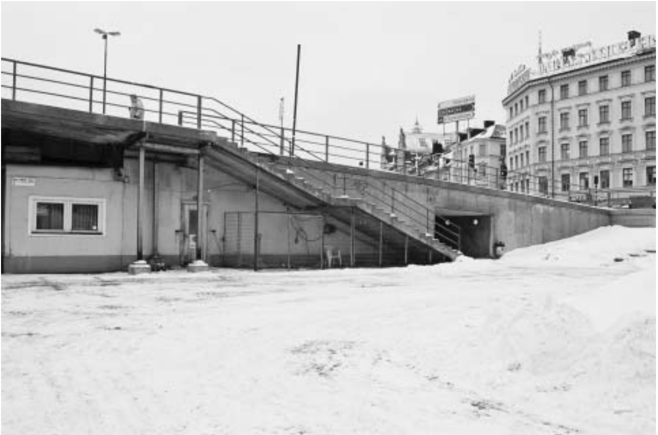
Lokal A, fasad mot öster. GF SF05-0008-27A.
