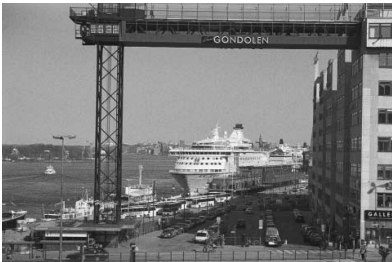
Vy från väster över Saltsjöutfartsrampen, med KF-huset på den södra sidan. GF S2005-0044-14.
