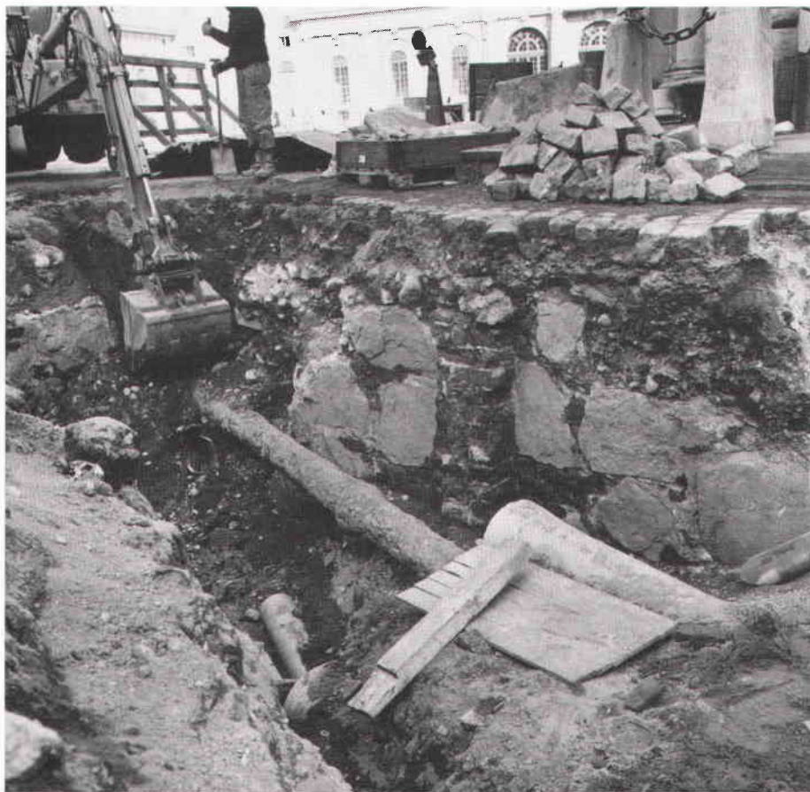
Hus 2 under framgrävning. Foto Kerstin Söderlund 1986. SSM.
