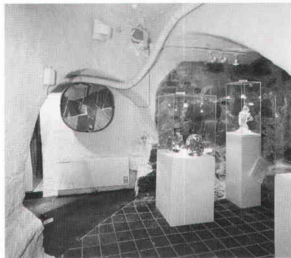
Latona 1. Den medeltida norra källarens svängande väst- och nordvägg. Från valvbågen t v skjuter en stor medeltida källare ut under nuvarande hushörnet. En sekundär stödvägg är ställd under fasaden mot Tyska Brinken. Foto Ingrid Wilken 1992. SSM.
