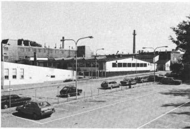
Fastigheten från NV
