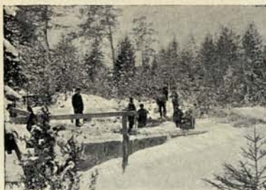
Grundläggning i Dufbo 1899.
