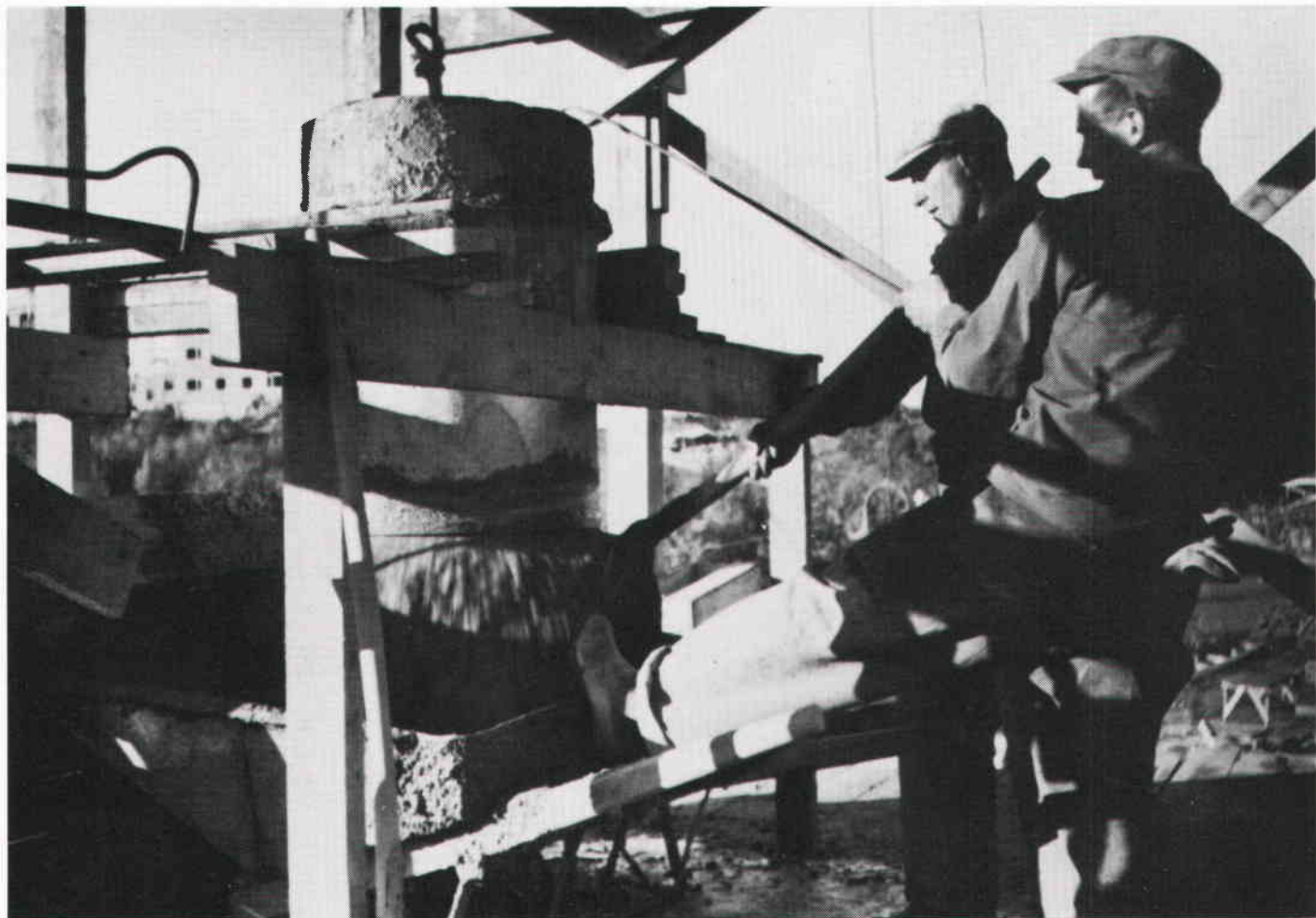
Arbetarna uppdelades i lag som tilldelades en speciell uppgift under hela bygget. Foto Andreas Feininger, 1939. Föreningen Stockholms Företagsminnens arkiv.
