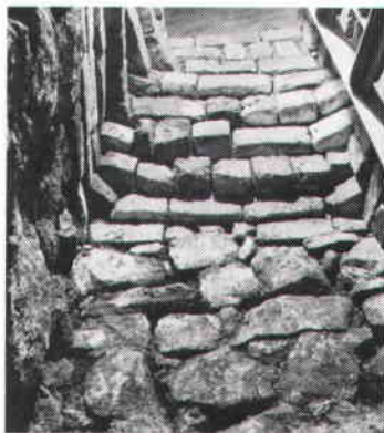
Utkragningen av tegelväggen nedanför öppningen inifrån brunnen.
