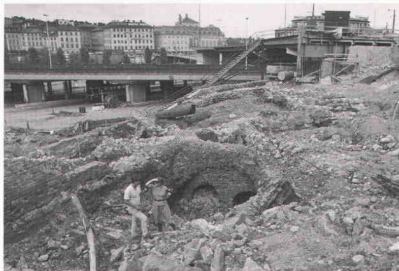
Vy från väster över utgrävningsområdet. Ett myller av byggnadslämningar från olika tider. Personerna på bilden står i det de la Gardieska palatsets huvudbyggnad. I bakgrunden skymtar de äldre byggnaderna anlagda efter det medeltida gatunätet. Foto Kent Lundqvist, Stockholms-Tidningen, juli 1984.
