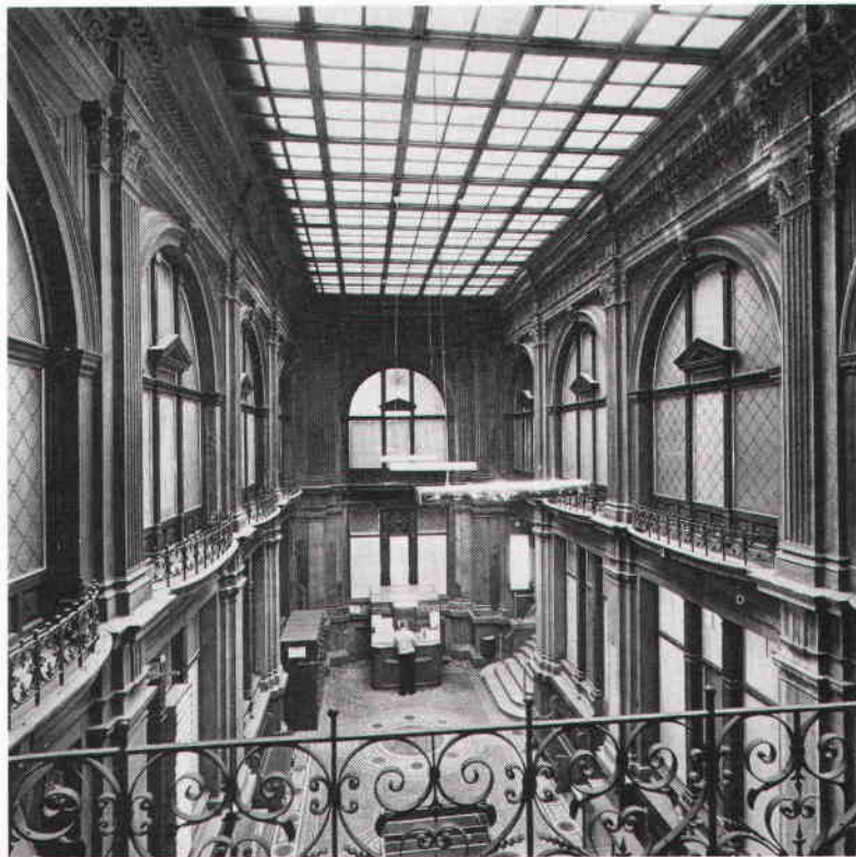
Sturebadets atrium. Vid 1900-talets början lades det plana glastaket in. Framme till höger ligger förbindelsegången till simhallen. I galleriaprojektet sätts denna öppning åter igen och atriet kommer att förbindas med gallerian genom ett dörrparti på fondväggen. Foto Göran Fredriksson 1981. SSM.
