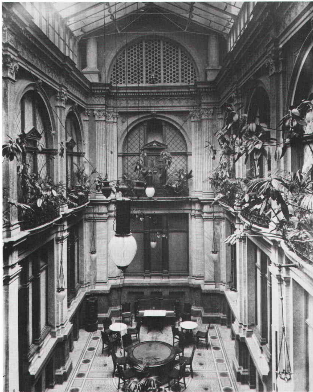
Sturebadets atrium med lanternintak, marmorerade pilastrar och glastäckta rundlar i cementmosaikgolvet. Foto 1896. SSM.
