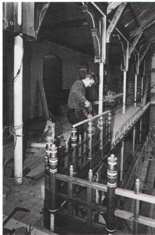
Sturebadets simhall, rekonstruktionsarbetet pågår. Foto Göran Fredriksson november 1988. SSM.
