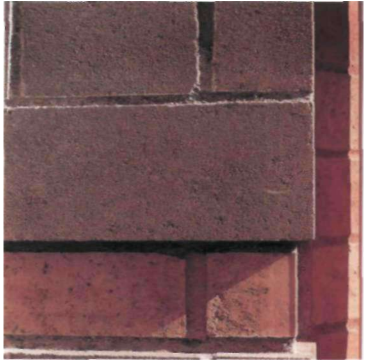
Detalj av tegelfasad vid Svartågatan.
