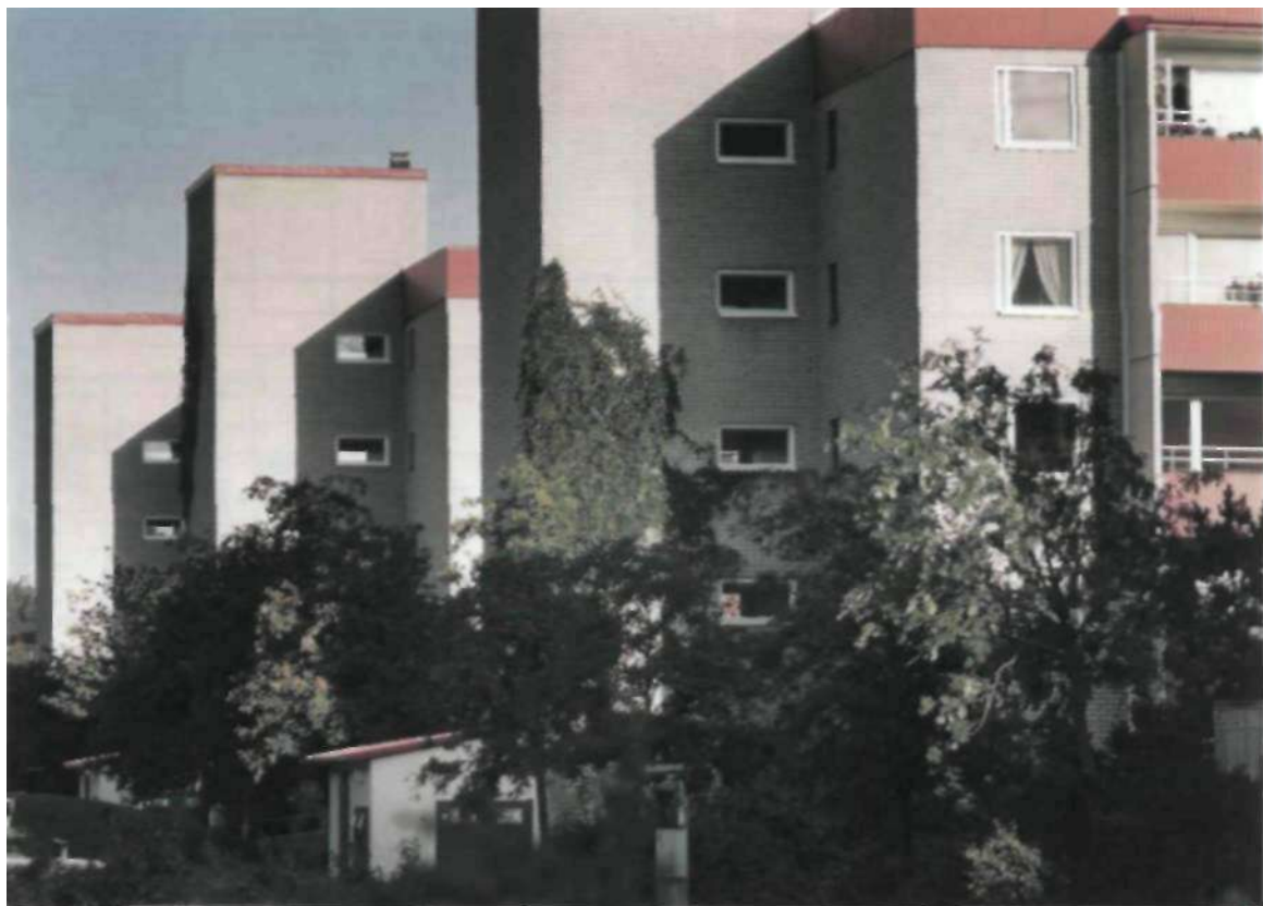
Loftgångshus vid Byälsvägen.
