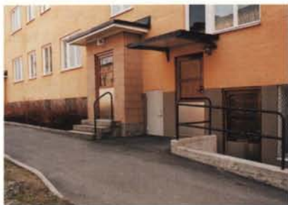
Den nya hissentrén på Kransbindarvägen har placerats bredvid den gamla renoverade porten.
