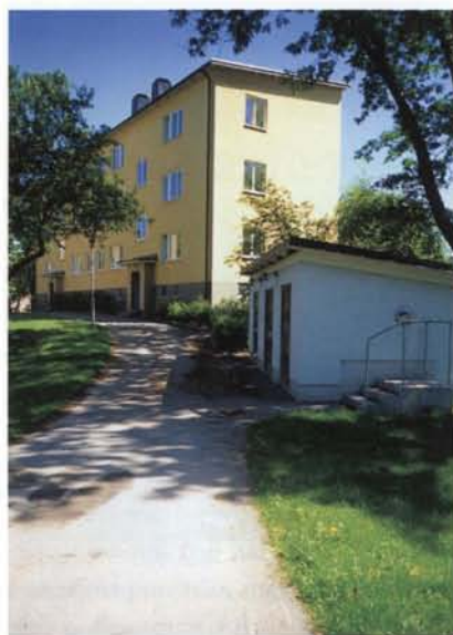
Många av husen har flacka pulpettak och putsade fasader. Fönstren placerade i fasadliv är stora och utan spröjs.
