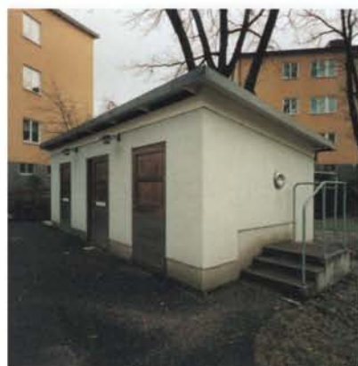
Utformningen av de nya sophusen för källsortering och grovsopor har anpassats efter de befintliga bostadshusen.
