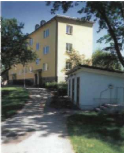
Många av husen har flacka pulpettak och putsade fasader. Fönstren placerade i fasadliv är stora och utan spröjs.
