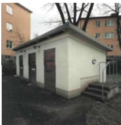
Utformningen av de nya sophusen för källsortering och grovsopor har anpassats efter de befintliga bostadshusen.
