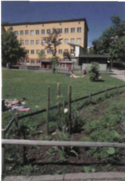
Svandammsgården på Cedergrensvägen 5-7 har använts till barnomsorg ända sedan den byggdes och innehåller numera både daghem och öppenförskola.
