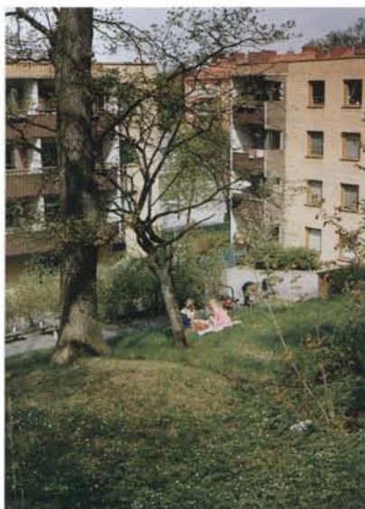
De platta taken och de släta fasaderna i ljus tegel med utskjutande balkonger är neutralt modernistiska i sitt uttryck.
