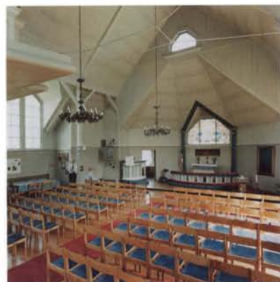
Kyrkans interiör är ljus och luftig, och takkonstruktionen sammanbinds av järnankare.
