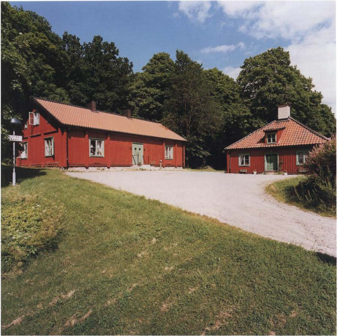
Sättagård idag. Exteriört förändrades gården något vid återuppbyggnaden efter branden 1966.
