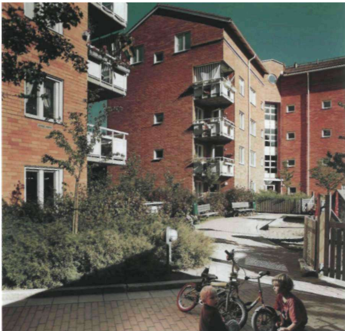
I Bagarmossen kompletterade Stockholmshem sina 50- och 60-talskvarter med ny bebyggelse nära centrum i slutet av 80-talet,
