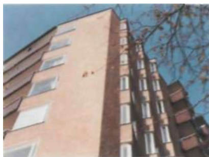
Lägenheterna i det höga centrumhuset byggs successivt om och anpassas för seniorboende.
