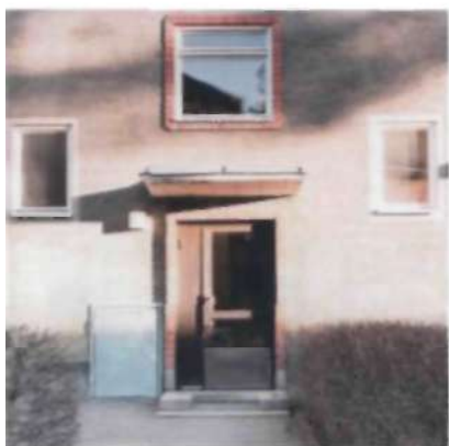
Port och trapphusfönster i Yrkesgatsområdet med karaktäristisk tegelomfattning.
