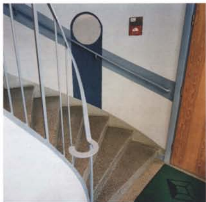
Trapphusen har målats om och sopnedkassen satts igen. Bränningevägen 24-45.
