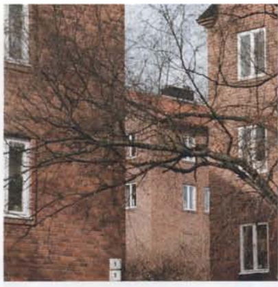
Teglet murades med omfattningar kring fönstren och takfoten markerades när barnrikehusen vid Möckelvägen och Bolmensvägen byggdes.
