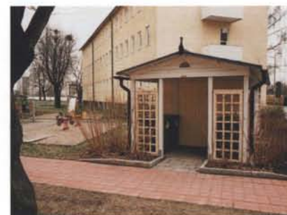
Ett nytt sophus för källsortering på gården vid Skattungsvägen 23-27 har utformats som en öppen pergola.
