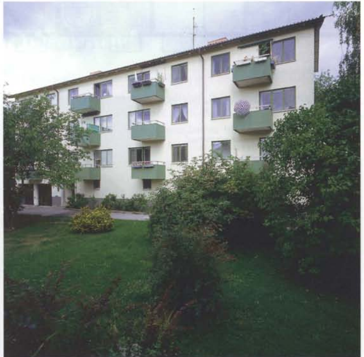
Huset vid Skattungsvägen 5-7 är slätputsat i ljusa färger.
