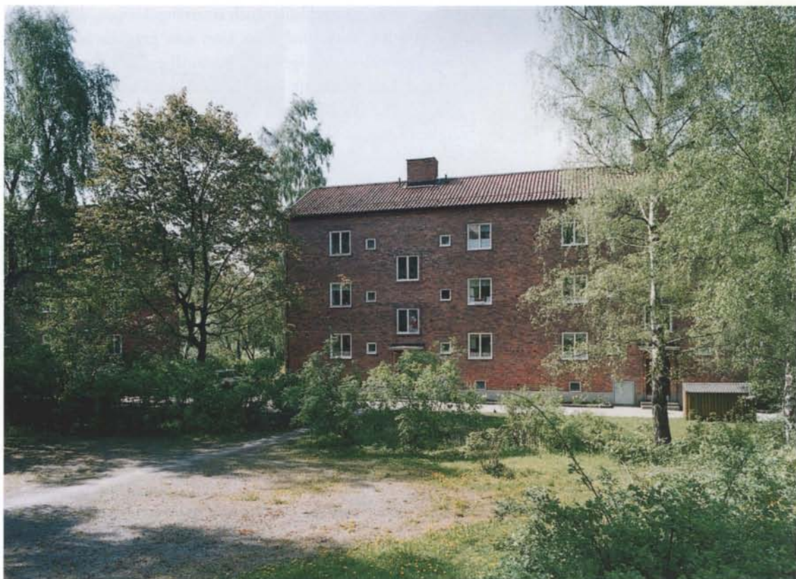
Skagersvägen 17–19 från gårdssidan.
