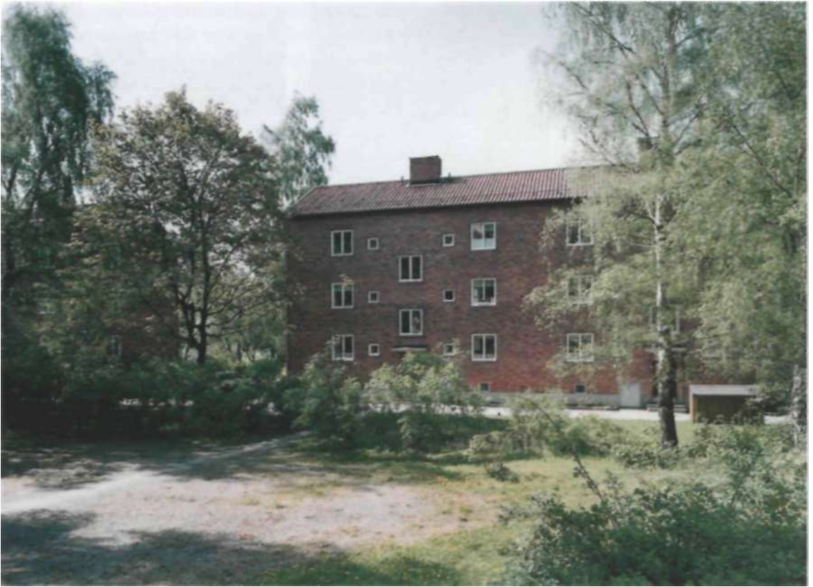
Skagersvägen 17-19 från gårdssidan.
