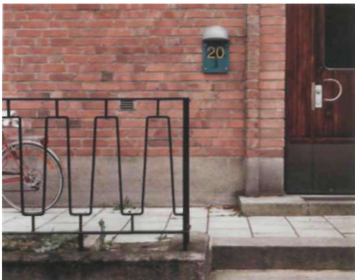
De ursprungliga ekportarna har renoverats. Tegelomfattningen kring porten och trappans smidesrücke är omsorgsfullt utformade.
