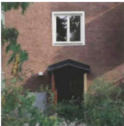
Ovanför entréportarna av ek sitter ett fönster som ger ljus till trapphuset. Fasaderna är av grov puts med vita släta band kring fönstren.
